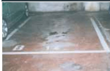
Sol de parking avant minéralisation.
