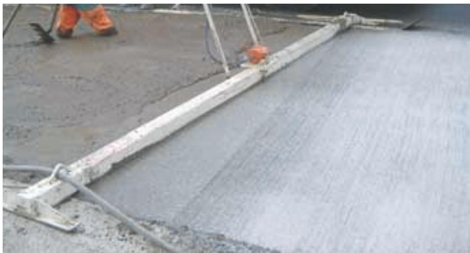
ciment alumineux fondu apporte, en effet, une réponse technique aux contraintes de délai et permet un durcissement rapide, l'obtention de résistances au jeune âge élevées et un séchage rapide avec un matériau durable. Ensuite, cette solution apporte une grande souplesse d'utilisation, par sa rapidité de mise en œuvre grâce à l'ouvrabilité du matériau, par l'obtention d'une bonne planéité par un lissage à la règle vibrante et par le pompage possible du matériau.
