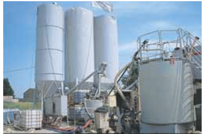
Station de fabrication du coulis de bentonite.
