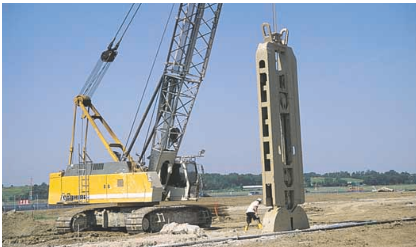
Creusement d'un écran étanche avec une benne à câble.
