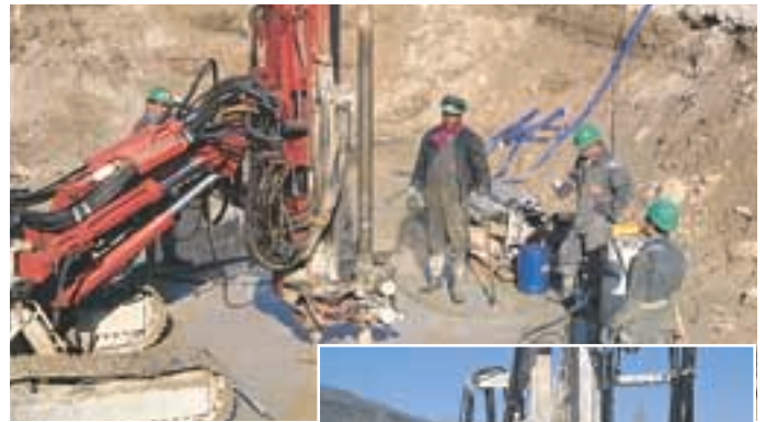
Ateliers de forage de "jet grouting".
