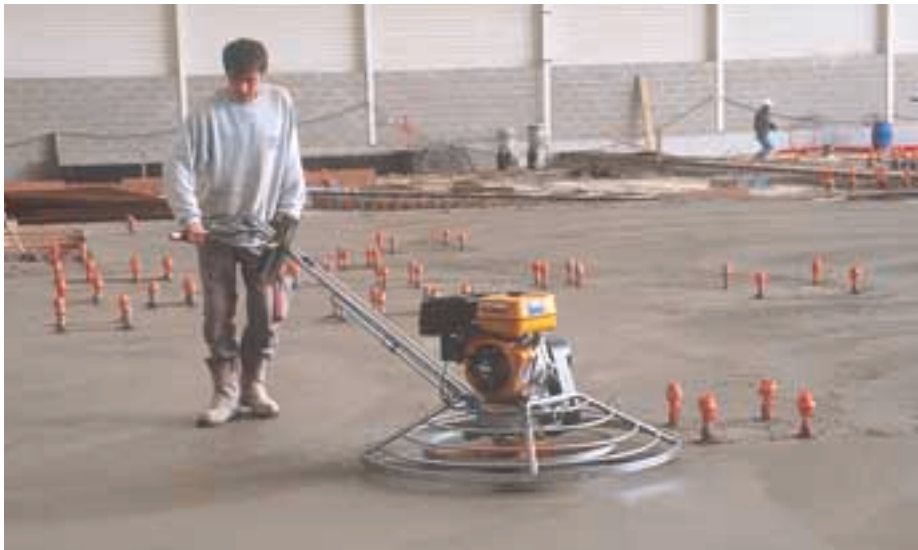
Le lissage à l'hélicoptère : technique courante des entreprises de dallage industriel.
