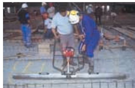
L'utilisation d'une règle vibrante accroît la productivité sur chantier.
