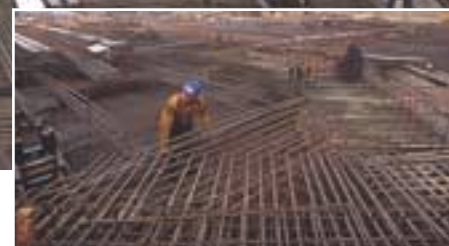
Le portique accueillant l’A380 est ancré sur de nombreux inserts et nécessite un nombre exceptionnel d’armatures.
