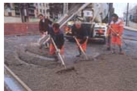
Le béton, acheminé sur chantier par camion toupie, est répandu et réparti au râteau.
