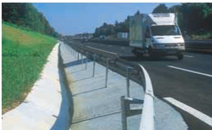
Les ouvrages hydrauliques en béton permettent de respecter la loi sur l'eau et son obligation de recueillir puis de filtrer les eaux de ruissellement avant de les rejeter dans l'environnement.
