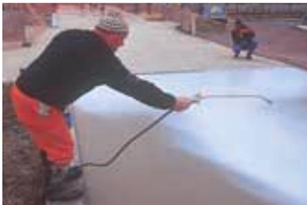
Pulvérisation du désactivant pour inhiber la prise du béton en surface.
