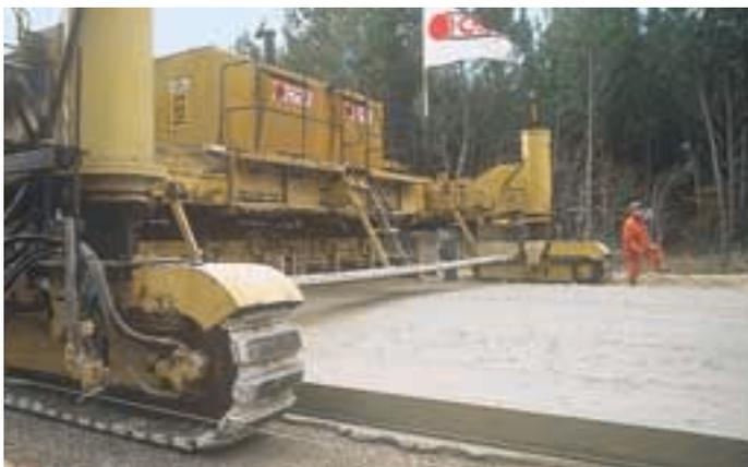
Le béton peut même être formulé à partir du sable présent localement, comme sur cette route expérimentale en béton de sable, à la dune du Pyla (Landes).
