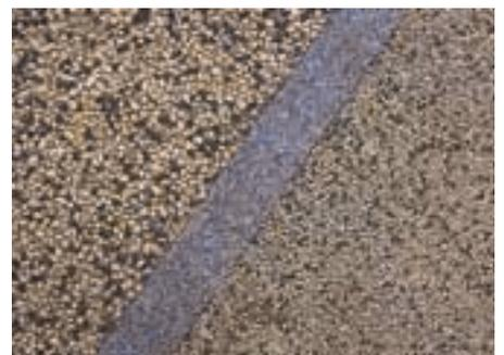
Les zones piétonnes sont réalisées avec des granulats basalte et un colorant ocre.
