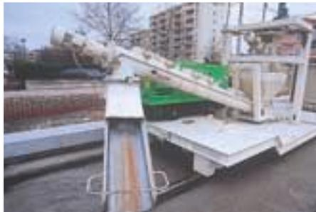
Engin à rampe déportée et orientable approvisionnant le béton entre les rails.
