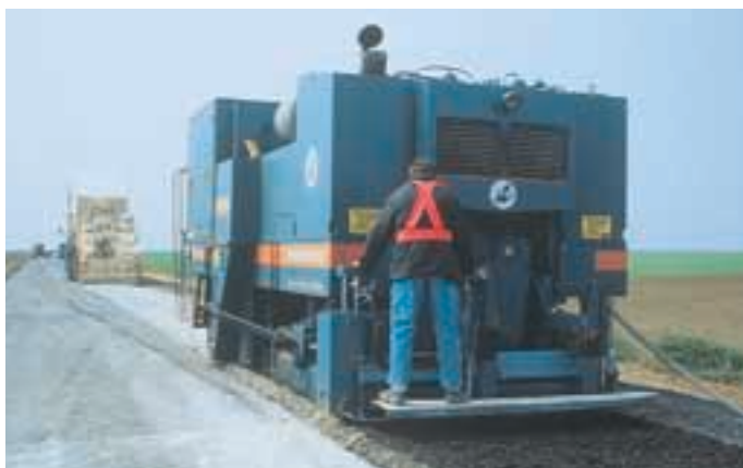
Le retraitement du sol en place au moyen de liants hydrauliques routiers épargne les ressources en granulats et supprime les nuisances dues à leur transport.
