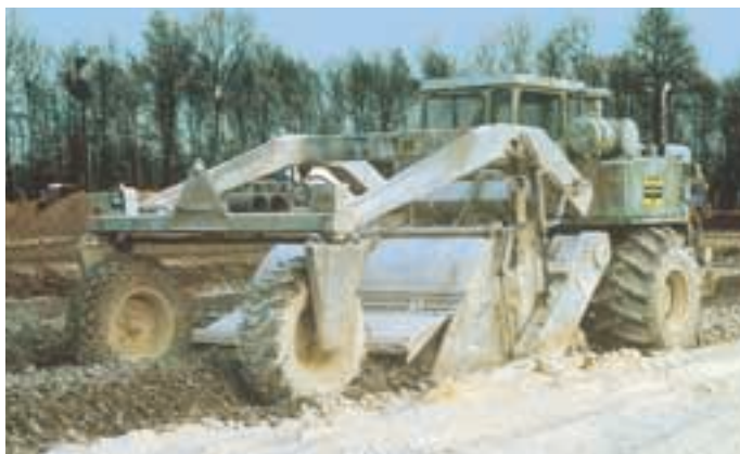
La technique du traitement à la chaux et au ciment est de plus en plus utilisée pour les terrassements, mais aussi pour la réalisation des chaussées elle-mêmes.
