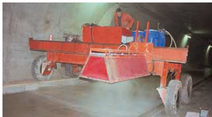
Machine d'épandage vaporisant, de façon uniforme sur la surface du béton armé, continu un agent désactivant qui inhibe la prise du béton en surface, afin de rendre les granulats apparents (béton désactivé).
