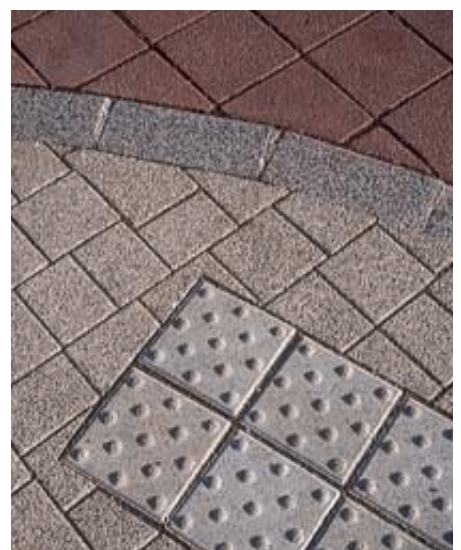
Les produits préfabriqués en béton offrent une grande variété d'aspects, de textures et de formats (ici dalles podotactiles).
