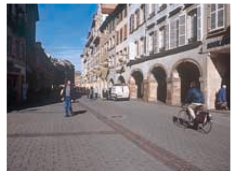
Rue Gutenberg : aménagement de dalles en béton, posées sur une structure drainante de béton poreux.
