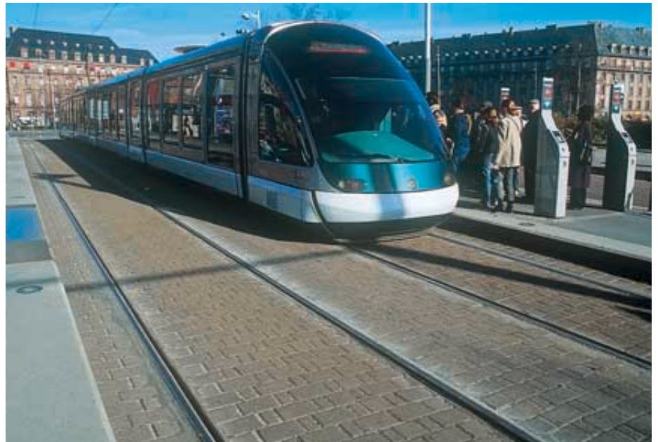
La plateforme du tramway a demandé la création de dalles et pavés béton à la géométrie spécifique pour disposer d'une épaisseur de revêtement de 10 cm.
