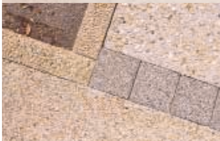
Place de la Mairie : une déclinaison de bétons désactivés, tant coulés en place que préfabriqués (bordures).
