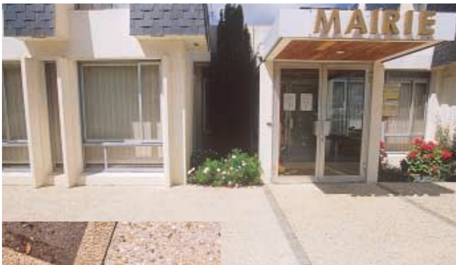
Place de la Mairie : une déclinaison de bétons désactivés, tant coulés en place que préfabriqués (bordures).
