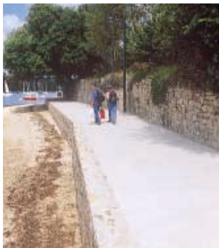
Chemin piétonnier en béton de sable blanc désactivé s'harmonisant agréablement avec la plage et la nature.
