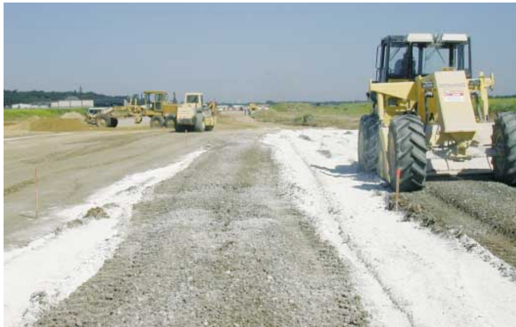
▲ Le sol est traité à la chaux sur une épaisseur de 35 cm. Crédit photo DDE 31.
