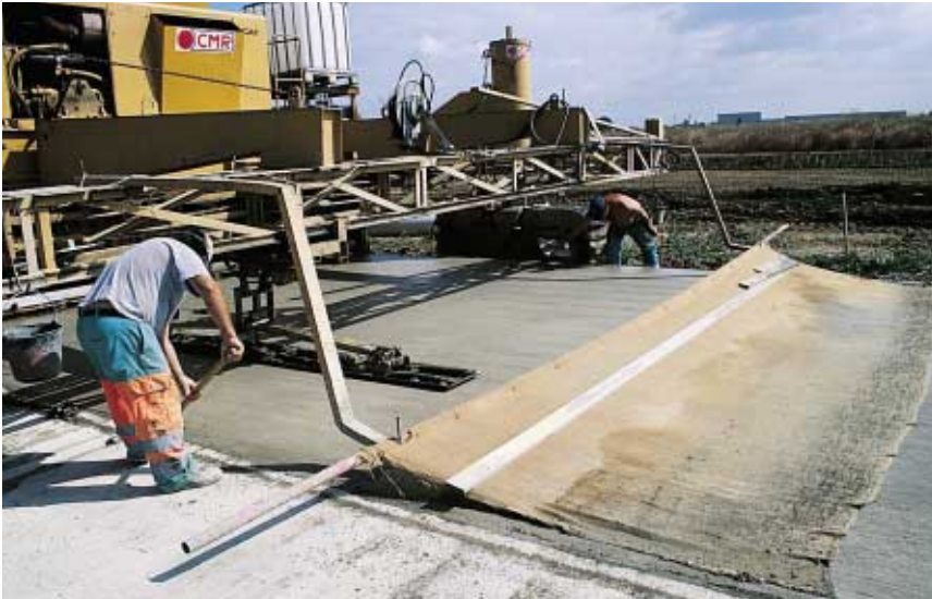
▲ Le passage d'une toile de jute humide unifie la surface de la dalle béton.
