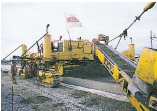
▲ La machine à coffrage glissant est approvisionnée en béton par un tapis d'alimentation de l'alimenteur général.
