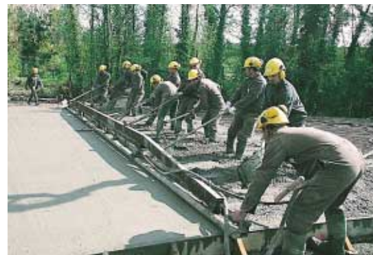
▲ Aussitôt après son coulage, le béton est vibré à l'aiguille. ▲ Une règle vibrante manuelle de 11 m de long a été spécifiquement réalisée pour ce chantier.
