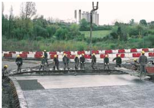
▲ Aussitôt après son coulage, le béton est vibré à l'aiguille. ▲ Une règle vibrante manuelle de 11 m de long a été spécifiquement réalisée pour ce chantier.
