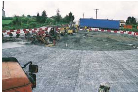
▲ Vue d'ensemble de l'anneau de béton du giratoire.
