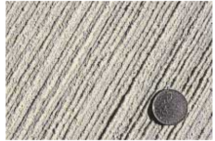
▲ Le balayage transversal donne à la chaussée la bonne adhérence nécessaire au freinage des avions.
