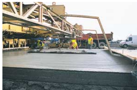
▲ Le talochage automatique lisse la surface du béton après le passage de la slip-form.
