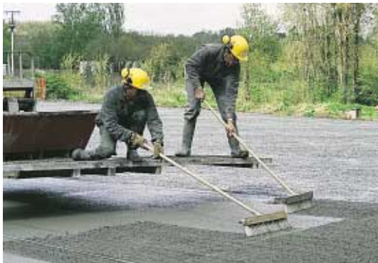
▲ Le balayage axial du béton frais donne à la chaussée une surface de roulement appropriée.
