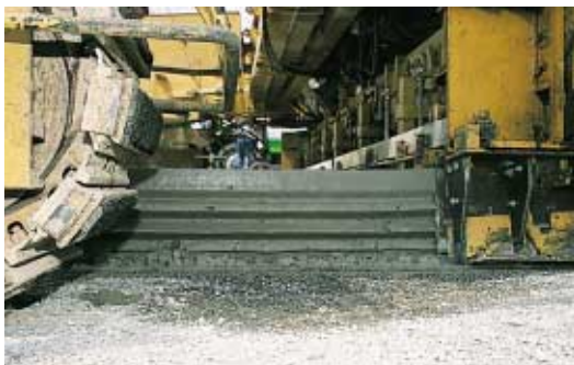
▲ Dessinées spécialement, les portes latérales de la slip-form forment le profil sinusoïdal du joint longitudinal.
