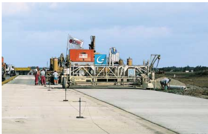
▲ Réglée sur 6,25 m de large, la slip-form avance à une cadence de 45-50 m/h.
