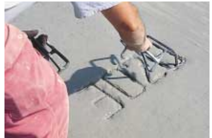
▲ Le marquage des dalles facilite leur repérage pour les opérations de maintenance de piste.
