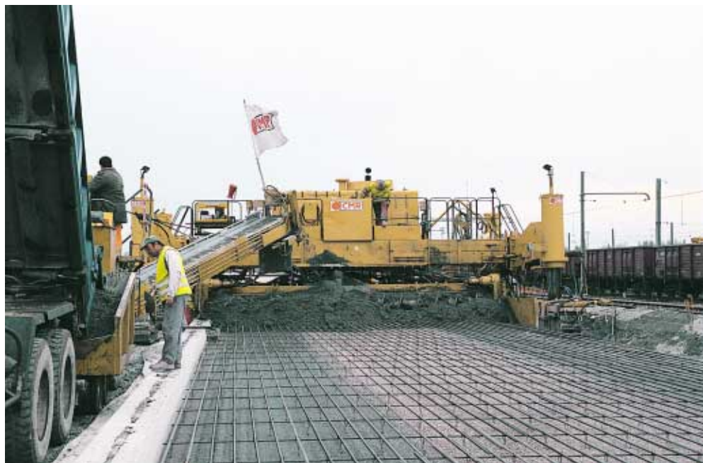
▲ 45 aciers filants posés sur distanciers arment la future zone de stockage en BAC.
