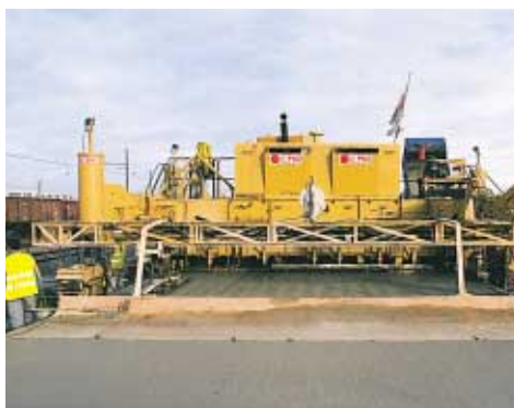
▲ Le passage d'une toile de jute humide unifie la surface du béton avant application du produit de cure.
