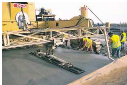
▲ Épaisse de 28 cm, la zone réalisée en BAC est destinée au stockage des conteneurs sur trois hauteurs.
