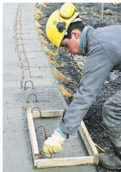
▲ L'insertion d'aiguilles métalliques solidifiera les futures bordures coulées en place avec la chaussée.
