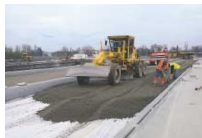
▲ Mise en place de la grave-ciment sur le géotextile avant compactage.
