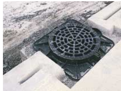
▲ Avaloir destiné à recueillir les eaux pluviales et à les diriger vers le drain des casiers-réservoirs.
