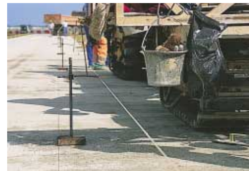
▲ Le guidage de la slip-form s'effectue par fil et palpeur.
