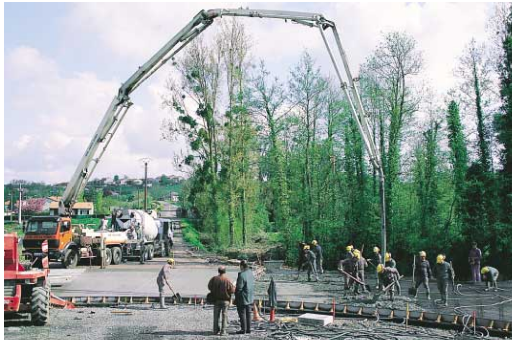
▲ Livré par camion-toupie, le béton est ensuite mis en place à la pompe pour faciliter sa répartition.
