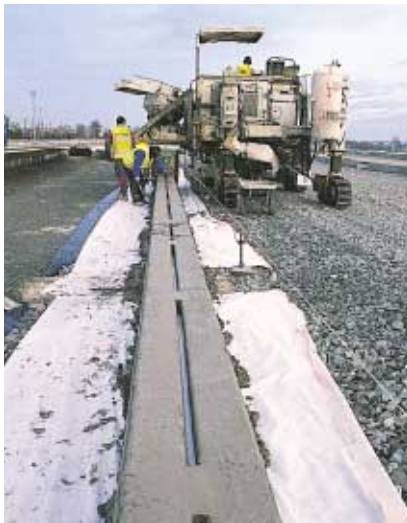
▲ Réalisation des caniveaux à fente en béton extrudé.
