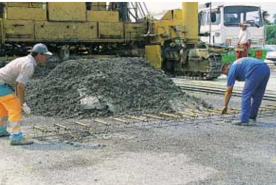
▲ Les goujons sont fixés sur un panier garantissant le maintien de leur bon positionnement pendant le coulage du béton.
