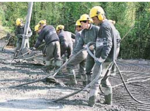
▲ Aussitôt après son coulage, le béton est vibré à l'aiguille. ▲ Une règle vibrante manuelle de 11 m de long a été spécifiquement réalisée pour ce chantier.
