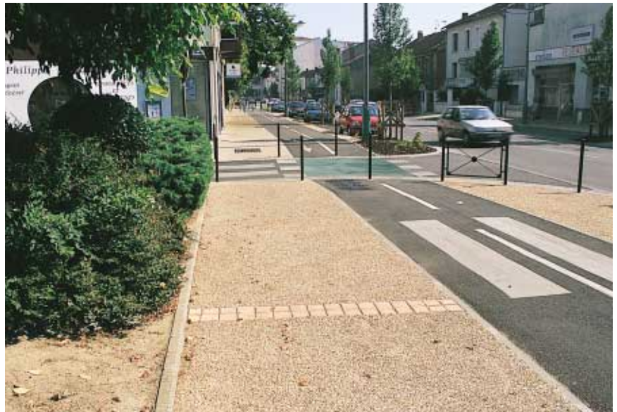
▲ Agen : sur le boulevard de la Liberté, chacun des utilisateurs de la voie – piéton, deux-roues ou voiture – dispose d'un espace dédié et clairement identifié par les revêtements du sol.
