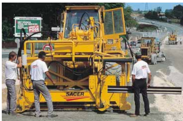
▲ Procédé Setec-Sacer : le joint est mis en place verticalement, en fond de couche de la grave-ciment.
