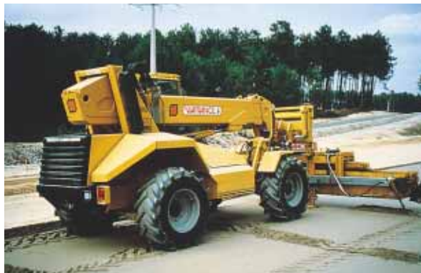
▲ Olivia : la nouvelle machine de préfissuration Viafrance.
