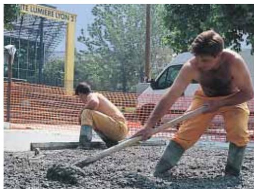
▲ Le béton frais est réparti sur le fond de forme, puis nivelé à la règle.
