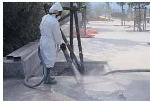
▲ Le sablage permet de rendre les granulats apparents, mais avec un contraste plus faible que la désactivation. Cette opération est menée par voie humide pour limiter l'émission de poussières et de déchets, 24 heures après le coulage, avant que le béton ait achevé sa prise.
