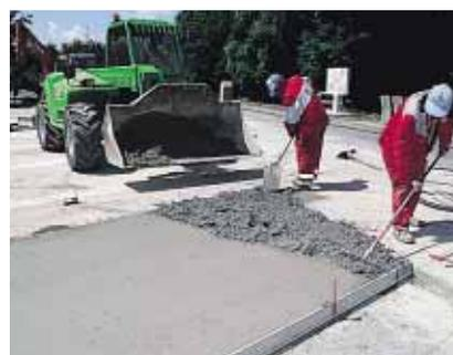
▲ Réalisées manuellement, les parties complexes doivent être soigneusement vibrées à l'aiguille.
