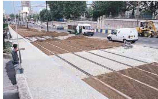
▲ À l'instar du tramway de Montpellier, de nombreuses zones non partagées avec l'automobile sont enherbées, afin de réintroduire le végétal dans la ville. Les passages pour piétons sont en béton désactivé.
