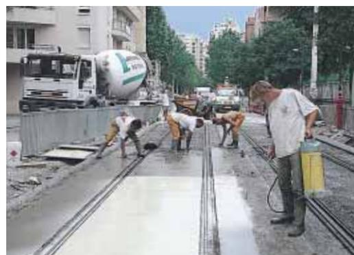
▲ Les zones à désactiver sont recouvertes d'un produit chimique qui inhibe l'hydratation du ciment en surface, 24 à 36 heures après le coulage.
