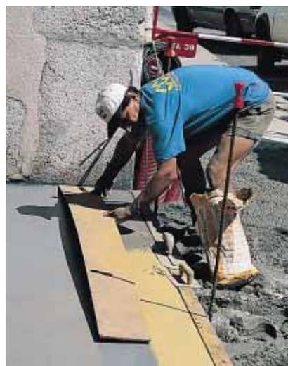
▲ D'autres moules permettent de réaliser les bandes jaunes des caniveaux.
