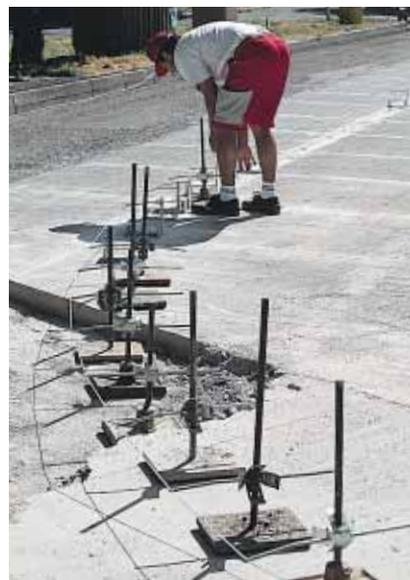
▲ Le rayon de braquage relativement court de la slip-form lui permet de réaliser les parties courbes avec un guidage par fil et palpeur.
