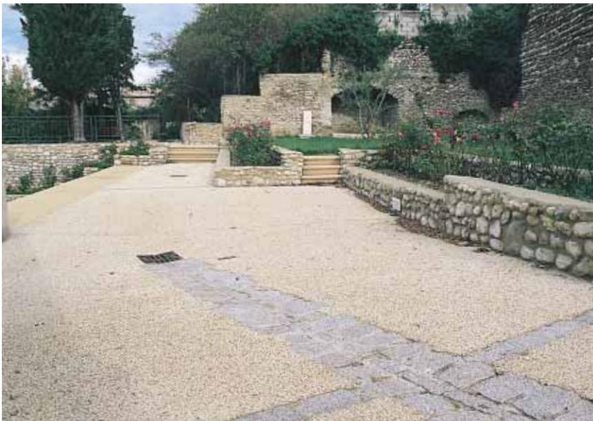
▲ Visan : outre les trottoirs de la traversée du village, Visan a fait appel au béton désactivé pour réaliser un aménagement piétonnier reliant la rue centrale à un petit square en surplomb.
