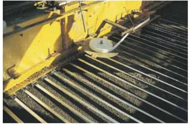
Entre 1995 et 1998, l'administration et la profession ont étudié et mis au point une structure innovante de type BAC + grave bitume, dont le dimensionnement laisse espérer une compétitivité économique vis-à-vis des structures bitumineuses épaisses.
