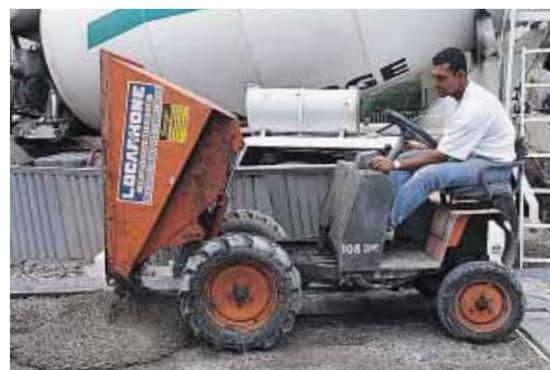
▲ Le béton est acheminé sur chantier par camion-toupie. Les zones les moins accessibles ont nécessité l'emploi de bennes de chantier plus maniables.
