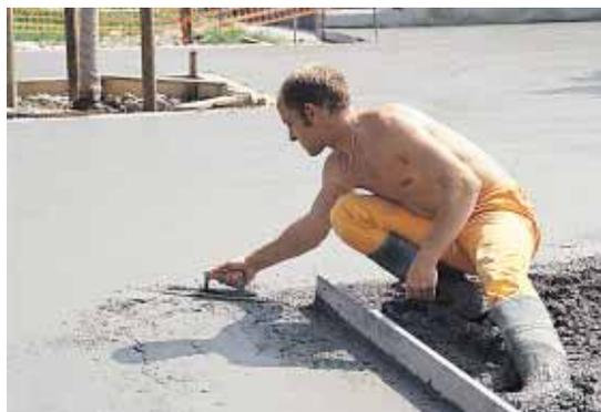
▲ L'uni de la dalle est obtenu par un lissage soigné de la surface.
