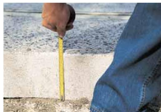
▲ L'épaisseur du béton est de 10 cm pour les zones piétonnières (béton sablé), de 15 cm pour les voies circulées et de 17 cm pour les carrefours très sollicités.
