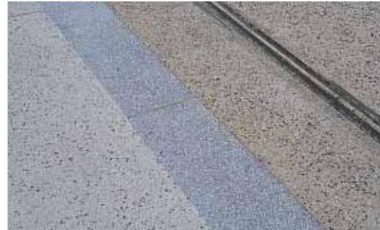
▲ Jouer sur la formulation et la finition du béton offre des possibilités esthétiques étendues. À gauche, un béton désactivé à base de calcaire blanc, à droite, un béton sablé avec un granulats silico-calcaire.
