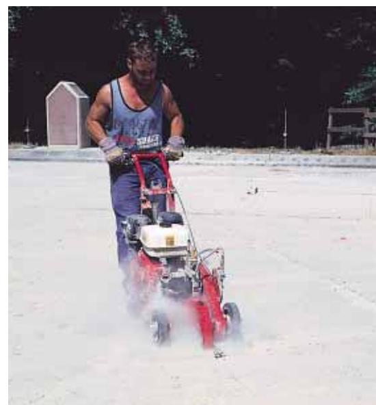
▲ Sciage *soft-cut* de la dalle de BCMC sur 2,5 cm d'épaisseur.
