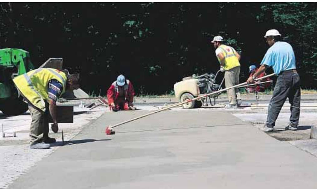
▲ Un balayage transversal confère une bonne rugosité à la chaussée.
