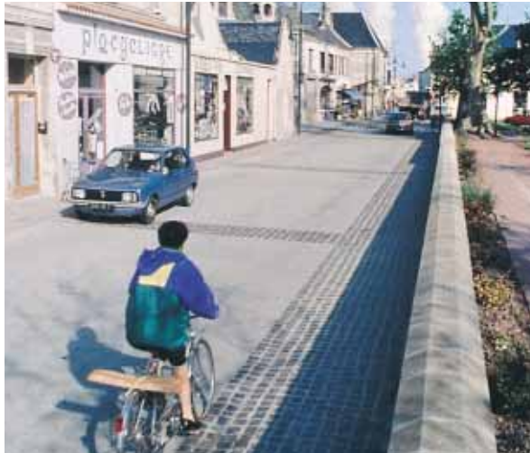
▲ Le mariage "béton-pavé" pour faciliter l'accès aux réseaux enterrés.
