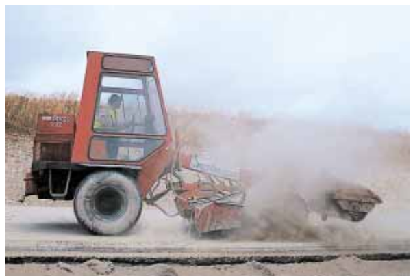
▲ 12 heures après le coulage, l'engin de brossage circule déjà sur la dalle.
