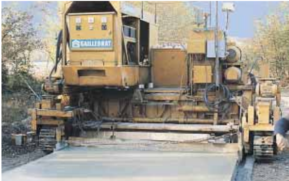
▲ Machine à coffrages glissants : rapidité et qualité d'exécution.
