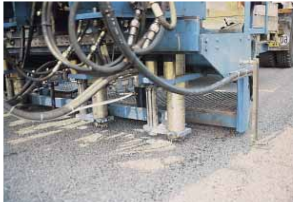
▲ Connecteur LCPC-Freyssinet, pour la restauration du transfert des charges au droit des joints.
