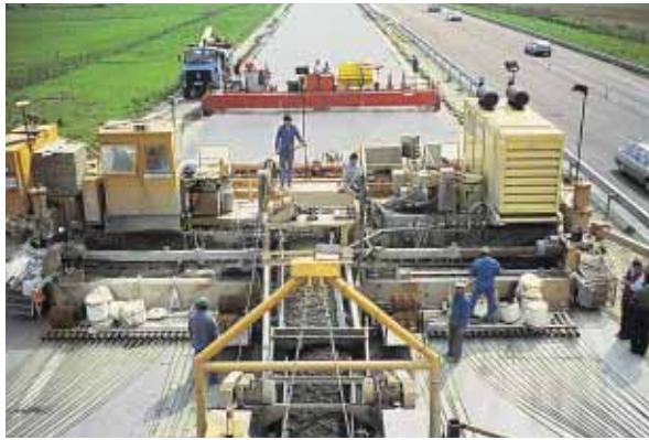
▲ Le béton armé continu (BAC).
