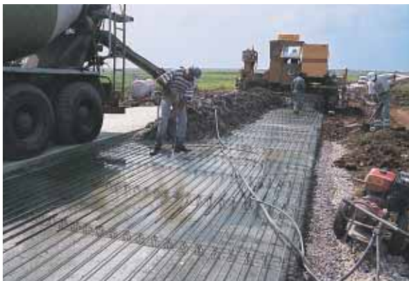
▲ Chantier innovant en béton armé continu collé sur une fondation en grave bitume.
