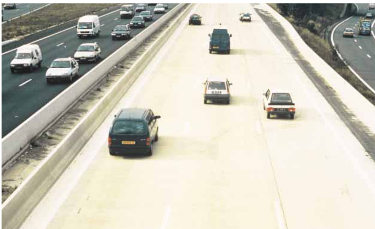
▲ Chaussée autoroutière en béton.
