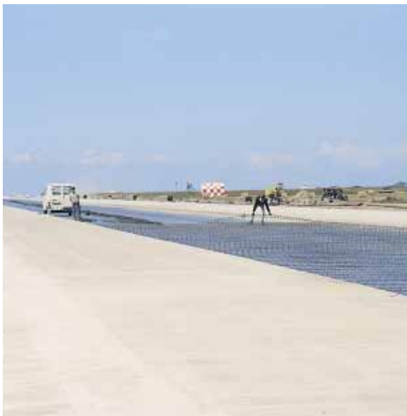
▲ Le béton pour la solidité (piste BAC de l'aéroport de Lorient-Lann-Bihoué).
