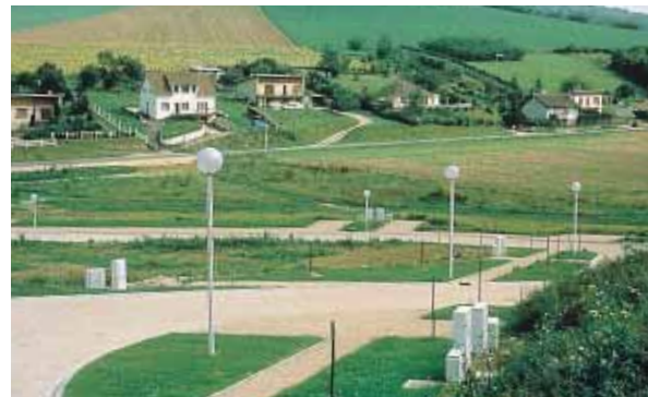
▲ Voirie de lotissement en béton : résistante, durable, esthétique, claire et sûre.
