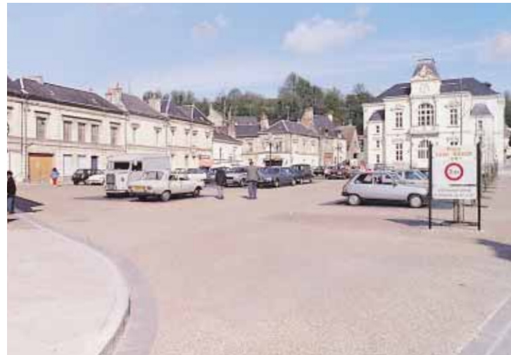
▲ Le béton désactivé pour le respect du style local.
