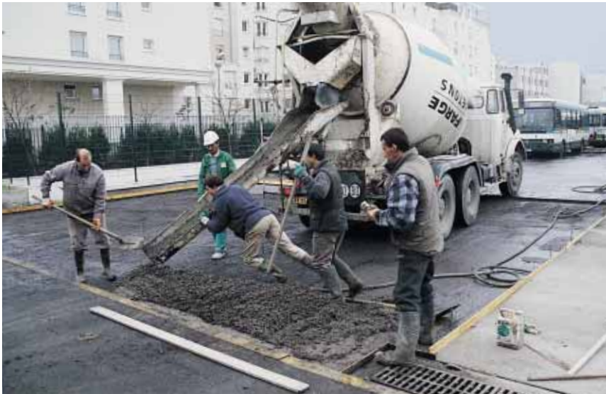
▲ Approvisionné par camion-toupie, le béton est sommairement étalé à la pelle.
