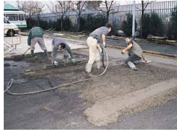
▲ Vibration à l'aiguille.
