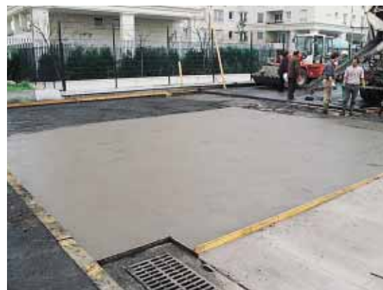
▲ Coulée le matin, la parcelle est réouverte à la circulation et au stationnement le soir même.
