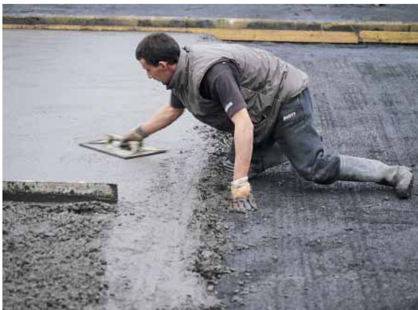
▲ On procède à un talochage soigné dans un délai très bref.
