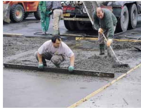
▲ Réglage sur une épaisseur moyenne de 8 cm.
