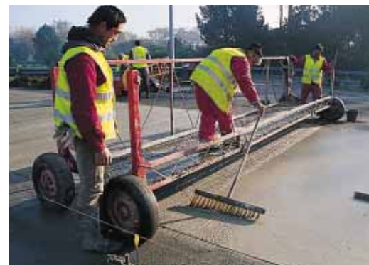
▲ On procède à un balayage transversal pour donner une bonne adhérence aux véhicules.
