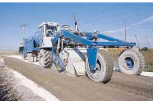
▲ Le malaxeur est équipé d'un rotor muni de dents au carbure de tungstène qui effectue un mélange intime des divers matériaux (chaussée existante, granulats d'apport recyclés, liant routier, eau) sur 30 cm d'épaisseur. L'alimentation en eau est assurée par une citerne montée dans la benne d'un camion poussé par le malaxeur.
