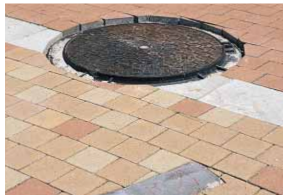
▲ ▼ Le traitement des zones non rectilignes a nécessité de nombreuses coupes sur mesure.
