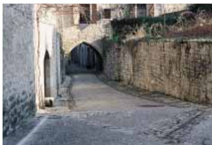
▲ Martel : l'ensemble de la vieille ville s'orne de rues en béton désactivé ; par leur texture et leur couleur, elles rappellent l'aspect des rues d'autrefois tout en apportant un confort moderne.
