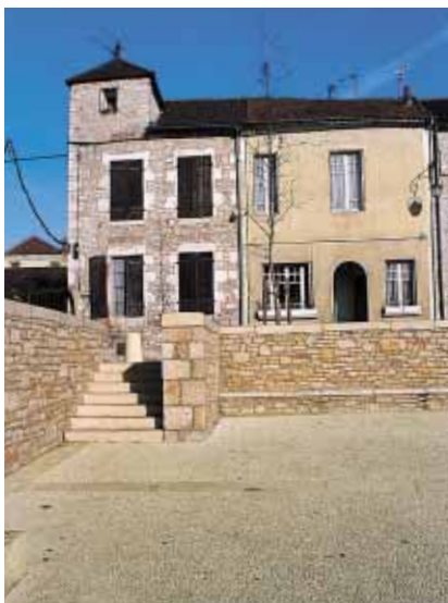
▲ Souillac : la place de l'abbatiale a été décaissée sur 1,50 m pour la ramener à sa configuration d'origine.
