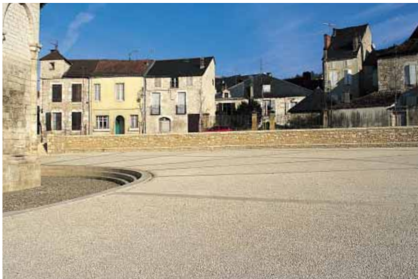
▲ Souillac : la réalisation de la place entre dans le cadre plus général de la mise en valeur du centre-ville, qui fait largement appel au béton désactivé.
