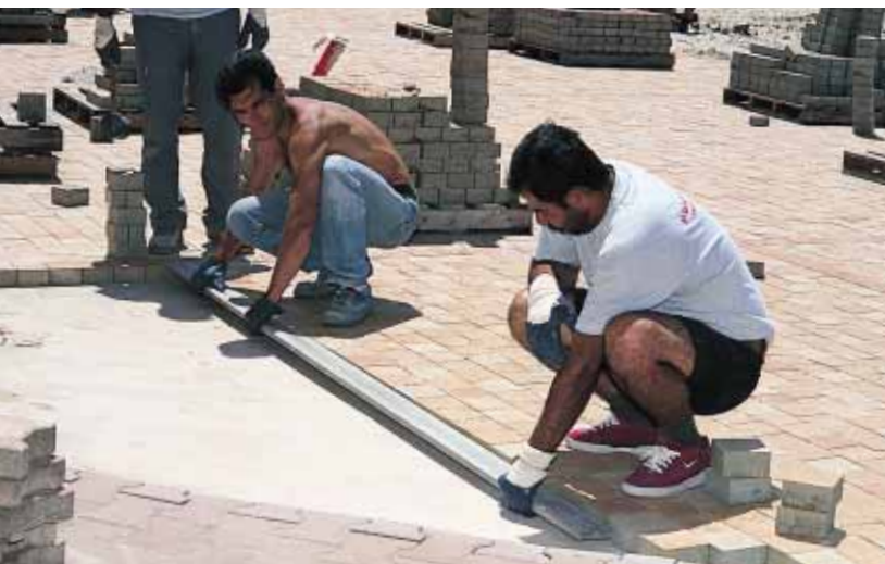
▲ Les pavés reposent sur un lit de sable de 4 cm qui doit être lissé avec soin à l'aide d'une règle supportée par une lame métallique afin qu'elle ne s'enfonce pas.
