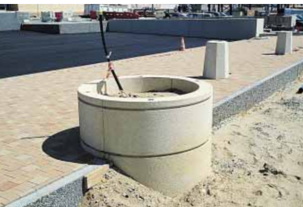
▲ Le préfabricant a fourni de nombreux produits en béton à base de ciment gris ou blanc teintés dans la masse : supports de candélabres, murs de soutènement, jardinières, etc.
