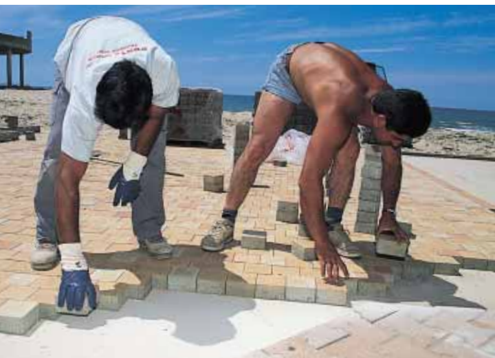
▲ Les pavés sont posés de façon jointive de manière à respecter l'alignement de départ, méthode qui exige de la part du fournisseur le respect de tolérances dimensionnelles très strictes (correspondant à la norme française Afnor NF P 98-303).
