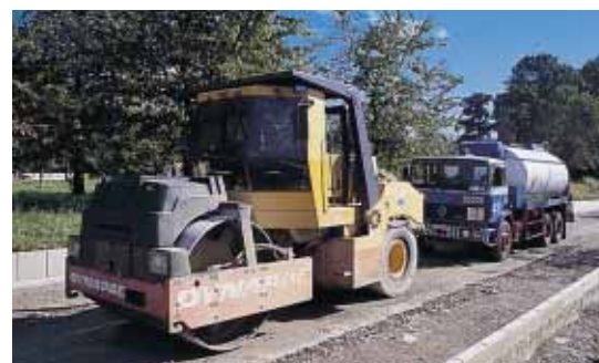
▲ La chaussée est réglée par le passage d'une niveleuse... puis compactée.
