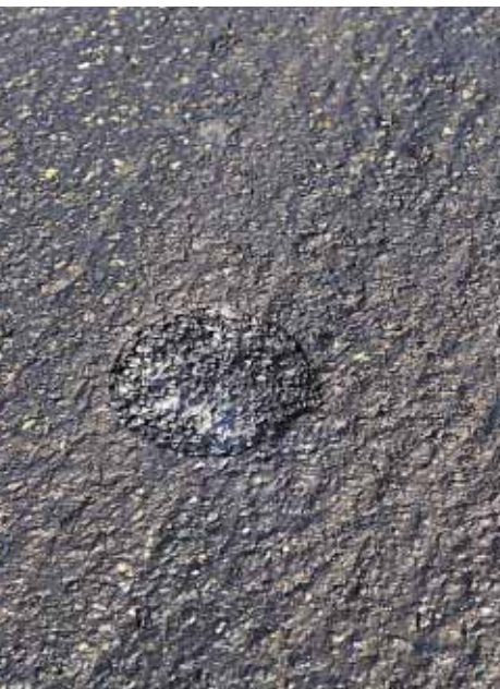
▲ On procède à un carottage pour connaître les caractéristiques de l'existant et calculer l'épaisseur de la couche de BCMC.
