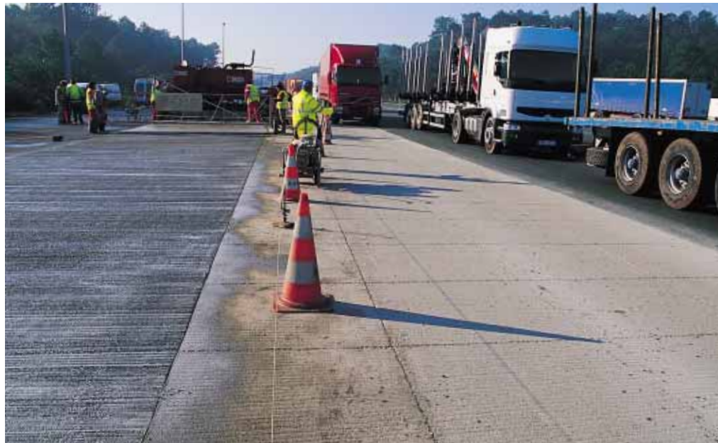
▲ Les voies de circulation sont réalisées une à une en raison de l'importance du trafic poids lourds.
