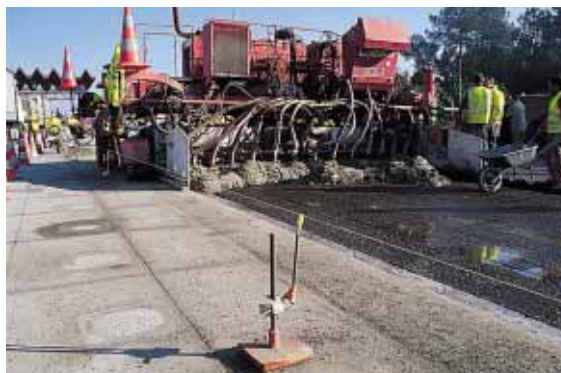
▲ Guidée par fil et palpeurs, la slip form met en place et vibre le béton sur une largeur de 5 m.
