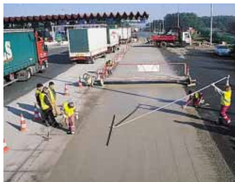
▲ Talochage après le passage de la machine.
