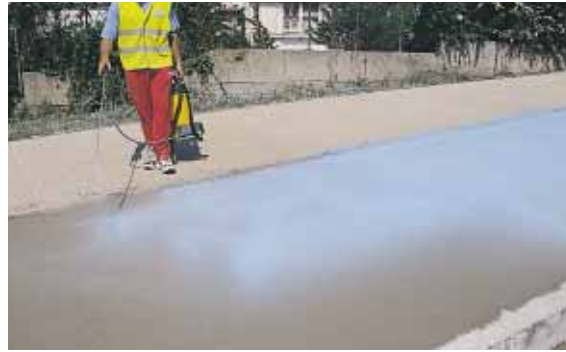
▲ Secteurs A et B – Le désactivant est appliqué au pulvérisateur et les dernières retouches sont effectuées à la taloche.
