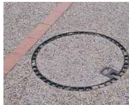
▲ Souci du détail, les regards sont eux aussi en béton désactivé.
