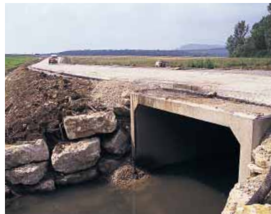
▲ Le ponceau sur lequel passe le BAC est réalisé à l'aide d'éléments préfabriqués en béton.
