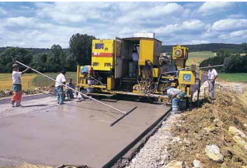
▲ Le lissage est réalisé après le passage de la slip form.
