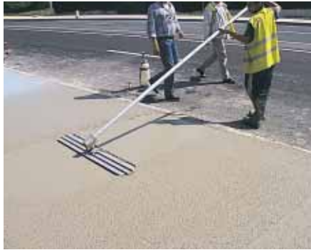
▲ Secteurs A et B – Le béton est fermé à l'aide d'une grande taloche avant application du produit désactivant.
