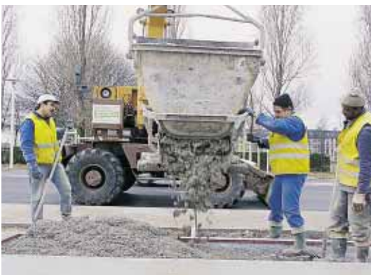
▲ Le béton est coulé à la benne dans les zones inaccessibles pour la rampe des bétonnières.
