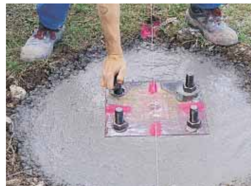
▲ L'implantation de chaque platine est soigneusement contrôlée.
