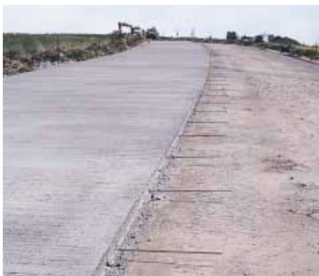
▲ Disposés tous les mètres, des aciers transversaux de 8 mm de diamètre assurent la couture du joint longitudinal.
