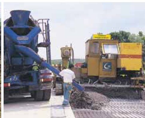
▲ Le béton est sommairement déversé par la toupie à l'avant de la slip form.
