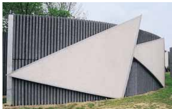
▲ ... revêtus de voiles absorbants en béton de bois et ciment blanc afin d'en signaler l'emplacement et de rompre la monotonie du traitement.
