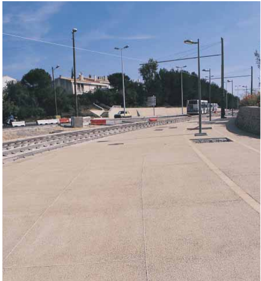
▲ Plus de 50 000 m 2 de béton désactivé auront été mis en œuvre sur les secteurs A et B.
