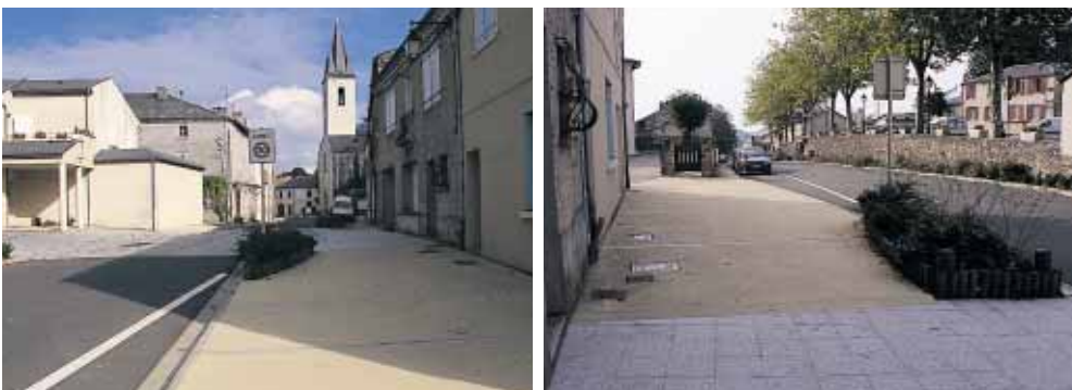
▲ Saint-Pierre-de-Trivisy : coulés en béton coloré, les trottoirs de la traversée du bourg offrent une plus grande sécurité aux piétons.
