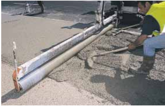
▲ Secteurs A et B – Le béton est constamment repoussé sous le cylindre pour que la dalle soit parfaitement compacte.
