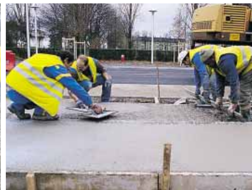
▲ Le béton est ensuite soigneusement taloché pour affleurer au niveau requis.
