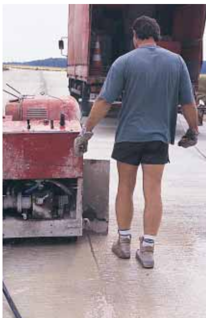
▲ Le sciage du joint longitudinal sera suivi de son remplissage par un produit bitumineux.
