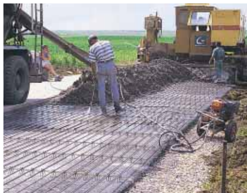
▲ Avant le coulage du béton, un lavage au jet de la fondation en grave-bitume permet de garantir un bon collage entre le béton et la grave-bitume.
