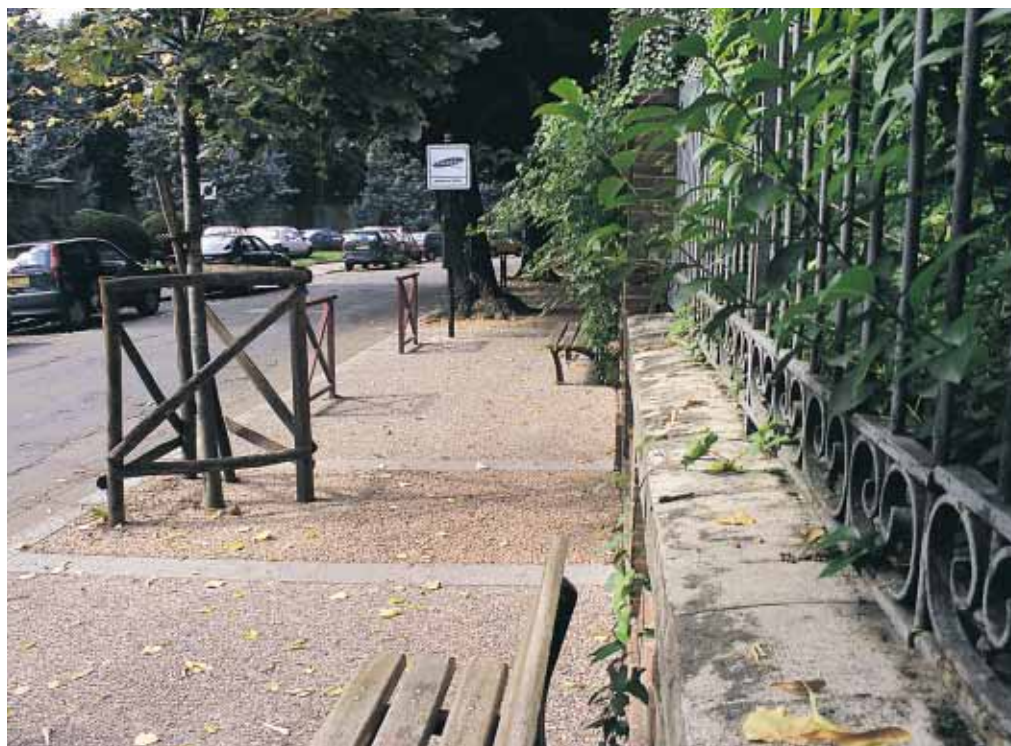
▲ Albi, trottoirs : la commune d'Albi a souvent fait appel au béton désactivé pour la réalisation d'équipements urbains de qualité.
