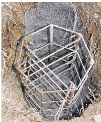
▲ Une cage d'armatures préparée en atelier arme le massif de fondation, ancré en profondeur dans le rocher calcaire afin de résister aux efforts transmis par l'écran sous la pression du vent.
