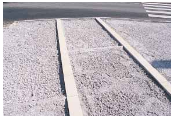
▲ Secteur B – Les joints et calepinages des trottoirs sont assurés par des règles Toffolo et des pierres naturelles qui permettent de marquer les espaces.
