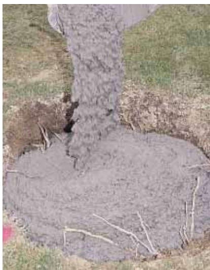
▲ Le béton prêt à l'emploi est déversé directement dans la fosse...
