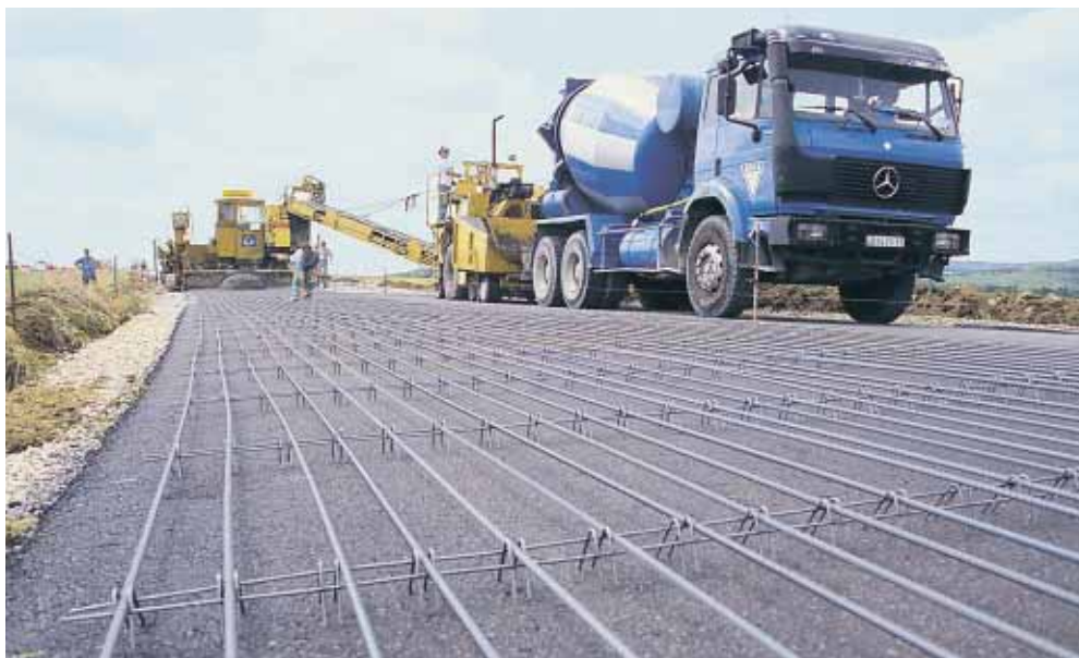
▲ Mis en place manuellement, les distanciers transversaux maintiennent un écartement constant de 13 cm entre les fers à béton longitudinaux et un positionnement régulier à mi-hauteur de la dalle.
