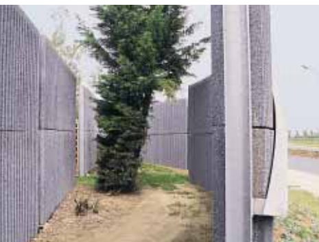
▲ Les entrées des passages sont protégées par une chicane réalisée à l'aide de panneaux cintrés...
