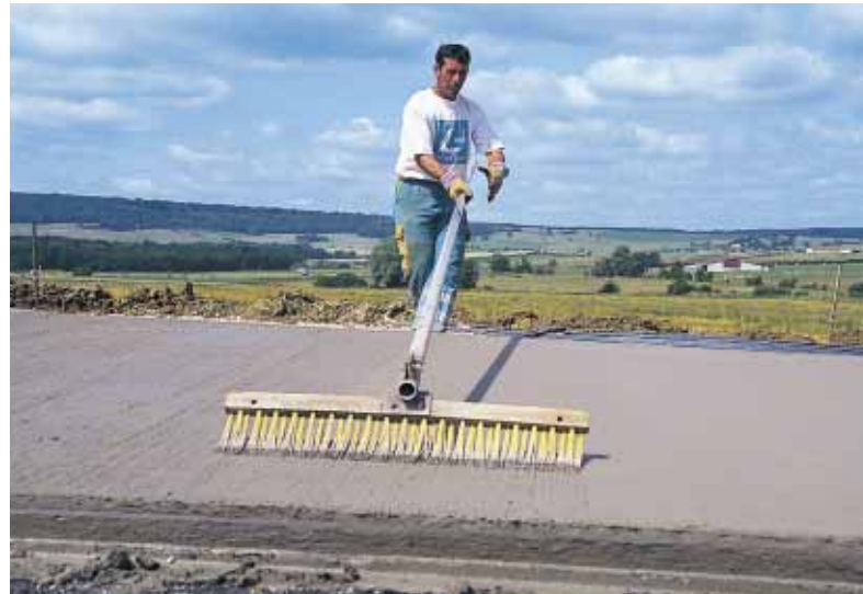
▲ Un balayage transversal donne à la chaussée la rugosité nécessaire à la circulation des véhicules.
