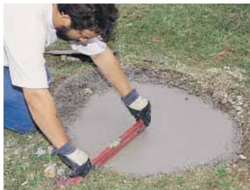
▲ ... puis réglé avec précision pour garantir l'horizontalité des platines de fixation.
