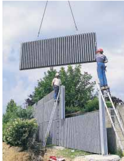
▲ Les modules de béton de bois, livrés directement sur chantier par le fournisseur, sont positionnés à l'aide d'une grue mobile.
