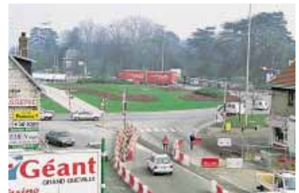
▲ Les travaux se déroulent sans interruption du trafic avec des moyens importants de déviation.
