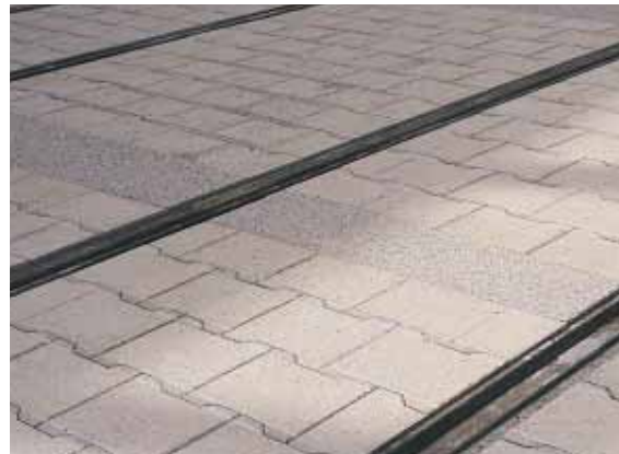
▲ Les "tranches de melon" sont comblées avec du béton désactivé.
