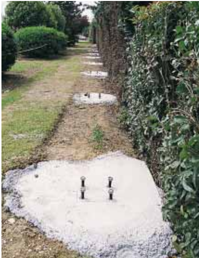
▲ Les supports sont prêts à recevoir les poteaux qui tiendront les écrans.
