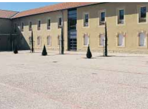
▲ Labruguière, centre de ressources : dans cette ancienne ferme, l'aspect naturel du béton désactivé s'accorde avec les enduits très chauds des bâtiments.
