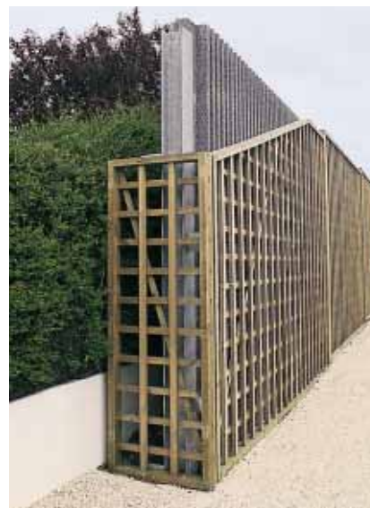
▲ Un treillis bois esthétique condamne l'accès à l'espace laissé entre les écrans acoustiques et les clôtures des parcelles privées.
