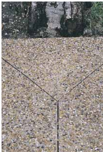
▲ La dalle à proximité des arbres est sciée pour prévenir les désordres.
