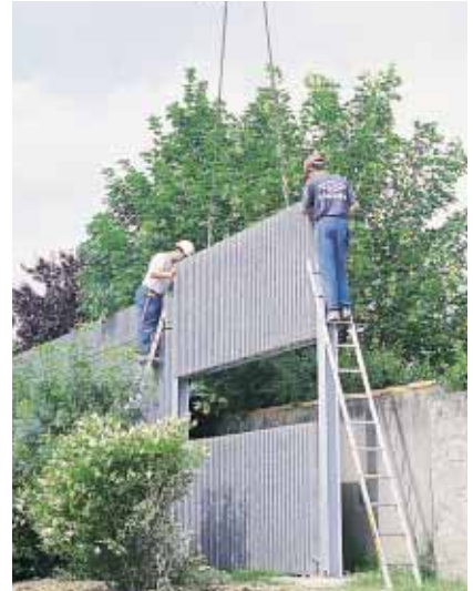
▲ Les panneaux, d'une largeur de 4 m et d'une hauteur de 1,50 m, 1 m ou 50 cm, couissent dans le profil creux du poteau HER de 160 mm de côté.
