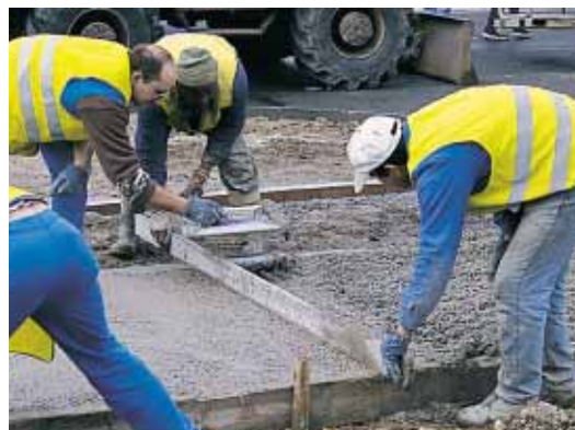
▲ Un premier nivellement est effectué à la règle.
