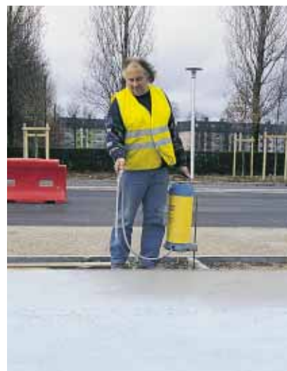
▲ Le béton est imprégné du désactivant Chrysolav P03.
