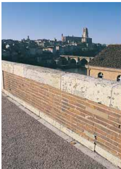
▲ Albi, pont Neuf : l'emploi d'un béton désactivé coloré a permis de réaliser des trottoirs qui s'intègrent parfaitement dans le cadre ancien de la ville.
