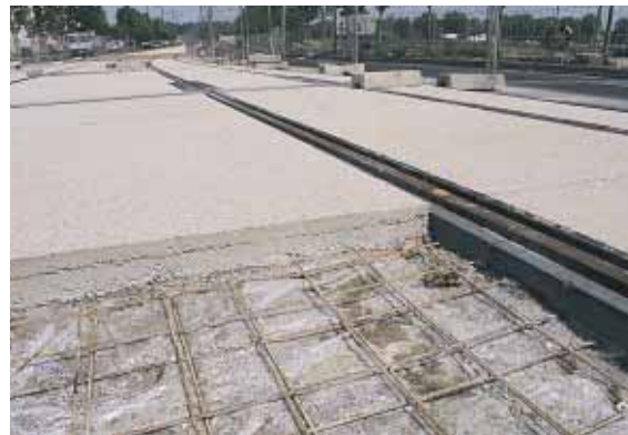
▲ Secteur E – Pour laisser libre l'accès au tablier du pont Zuccharrelli, des dalles amovibles ont été coulées sur un lit de gravier et un film polyane.
