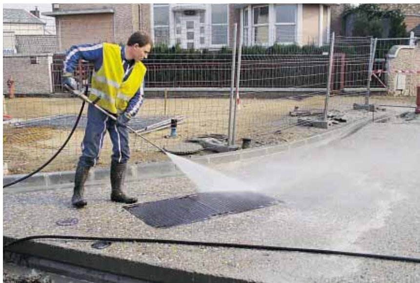
▲ Le lavage doit être fait dans les 24 heures suivant l'application.
