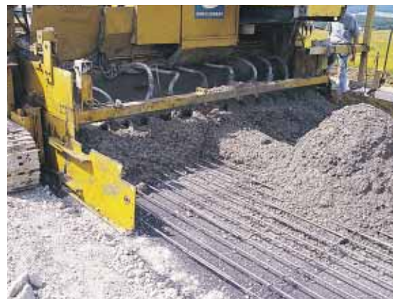
▲ La slip form assure le coffrage et la vibration du béton de chaussée en un seul passage.
