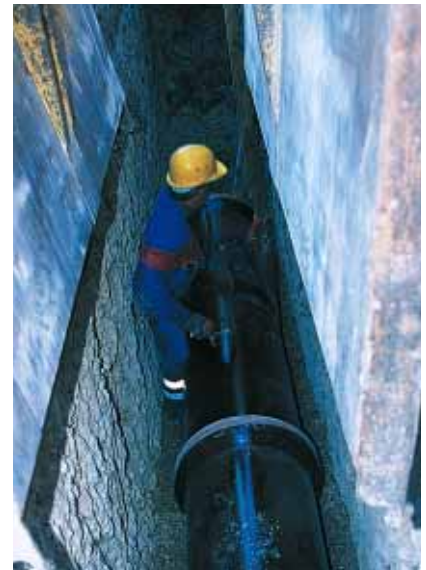
▲ Les canalisations qui reposent sur un lit de sable sont alignées au laser et emboîtées après avoir été encollées au niveau de la “tulipe”.
