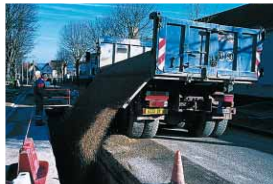
▲▼ Les conduites qui reposent au fond de la tranchée sont recouvertes de gravillons.
