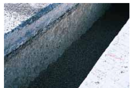
▲▼ Les conduites qui reposent au fond de la tranchée sont recouvertes de gravillons.
