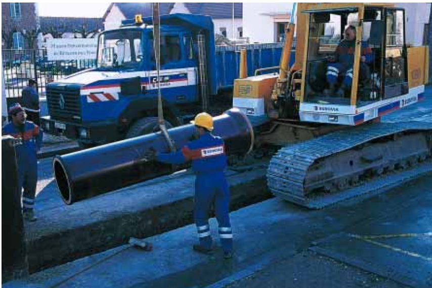
▲ Les canalisations qui reposent sur un lit de sable sont alignées au laser et emboîtées après avoir été encollées au niveau de la “tulipe”.
