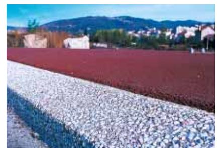
▲ Unieux : les bordures en béton désactivé réalisées avec du quartz des Pyrénées ont un pouvoir réfléchissant très important qui permet de mieux baliser la voie.
