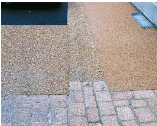
▲ L'emploi de deux désactivants d'intensité différente permet de mettre plus ou moins en relief les granulats afin de distinguer deux zones.
