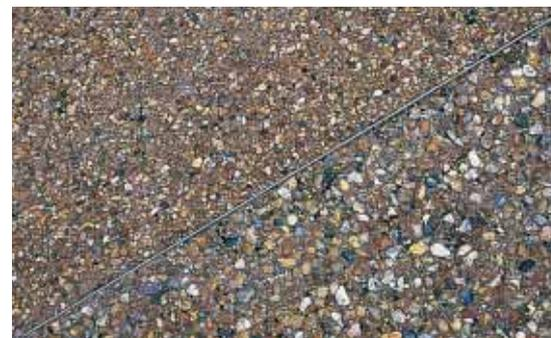
▲ Tous les 5 m, des joints sont réalisés sur le tiers de l'épaisseur de la dalle.
