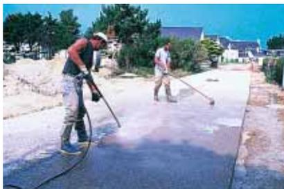
▲ Après une nuit de séchage, le béton est lavé à haute pression.
