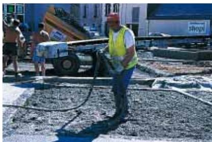
▲ La couche inférieure du béton est vibrée à l'aiguille.
