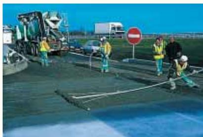
▲ Mise en œuvre du BMC. Vibration à l'aiguille vibrante et lissage de la surface du béton.
