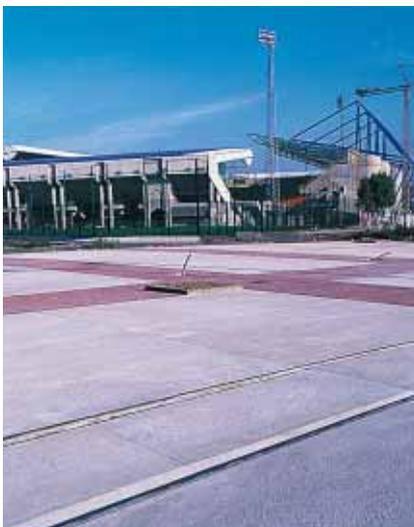
▲ Saint-Étienne : la combinaison d'un béton balayé et d'un béton désactivé a permis d'inclure facilement la voie de chemin de fer au cœur même de l'esplanade.
