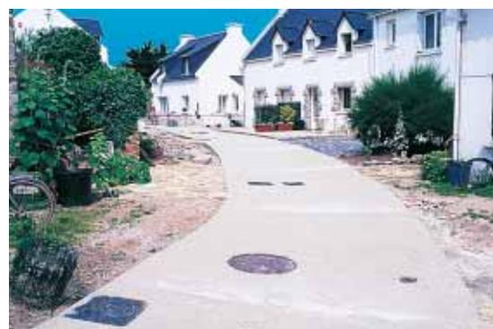
▲ Les joints de retrait sont réalisés par sciage tous les 3,25 m.
