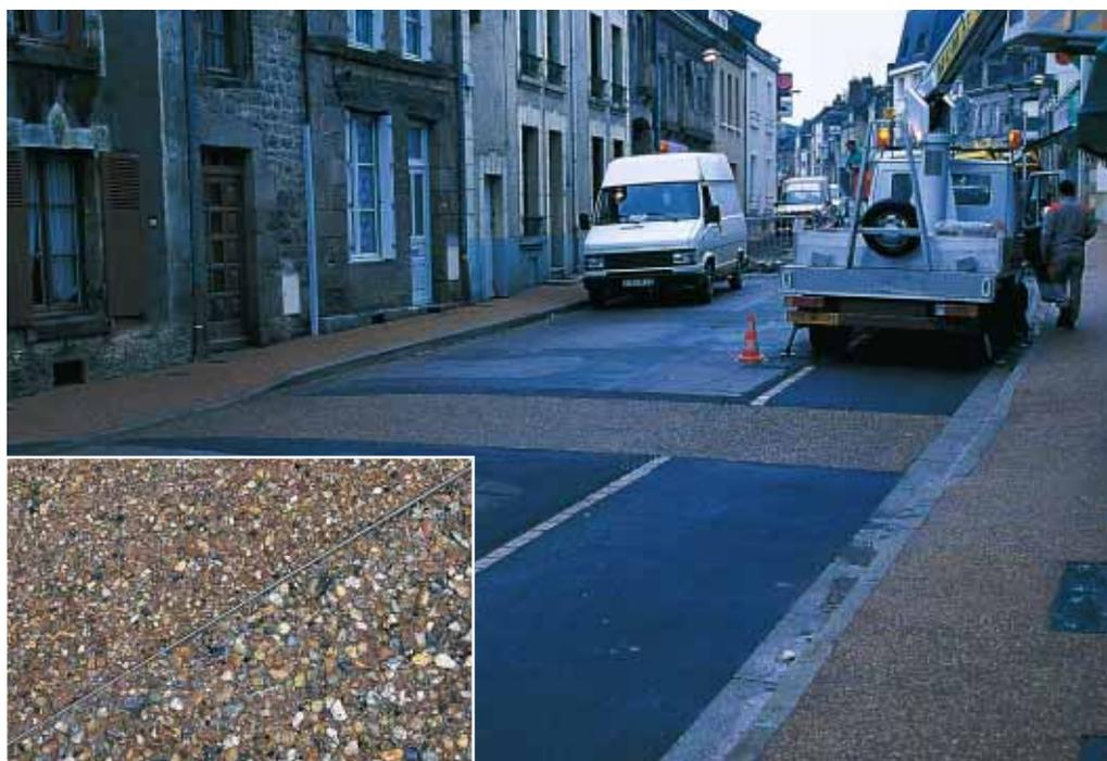
▲ Les trottoirs emploient du béton fibré, teinté et désactivé sur une épaisseur de 12 cm, tandis que 22 cm sont nécessaires pour les zones soumises à la circulation, avec renforcement au moyen d'un treillis soudé.
