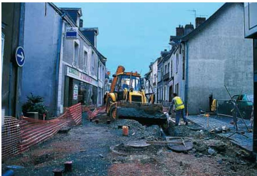
▲ Le décaissement sur une trentaine de centimètres sera suivi de l'application d'une épaisseur de graves non traitées, compactées avant le coulage du béton.
