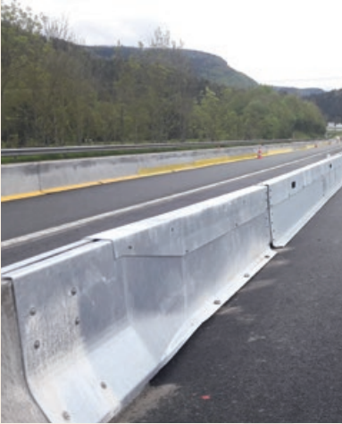
La nouvelle interruption de terre-plein central (ITPC) de l'A40, au sud d'Oyonnax.
