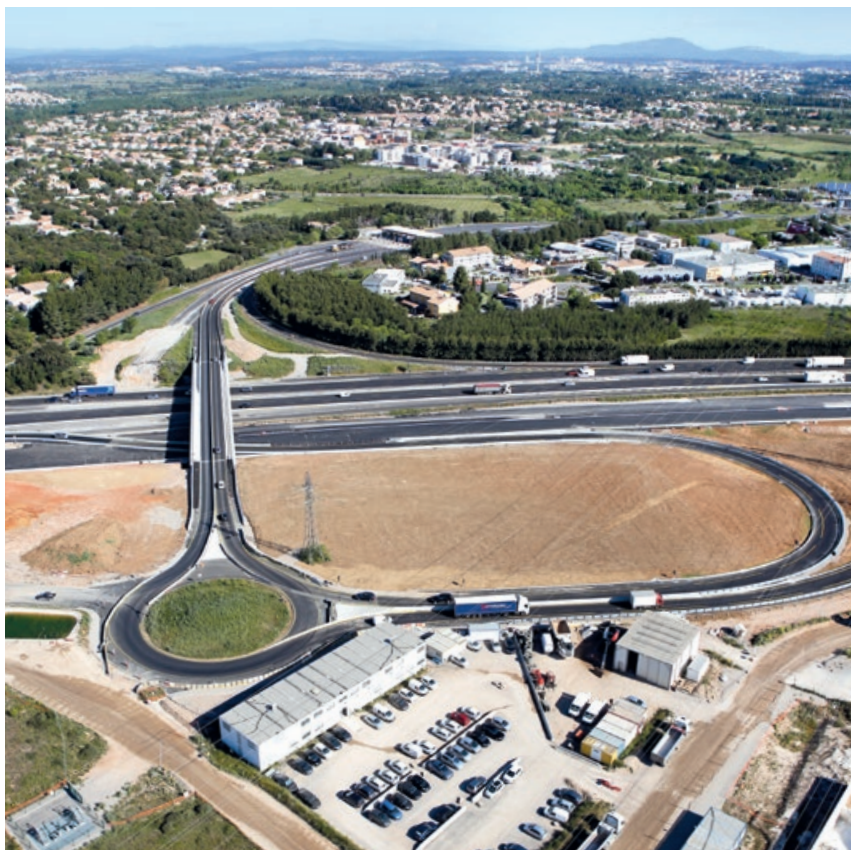
Le chantier de l'élargissement de l'autoroute A9, près de Montpellier. Entre les points kilométriques 100 et 110, AER a mis en œuvre 13 000 m 3 de béton pour réaliser les glissières et 6 500 m 3 pour les cunettes, les caniveaux en U et les caniveaux à fente.
