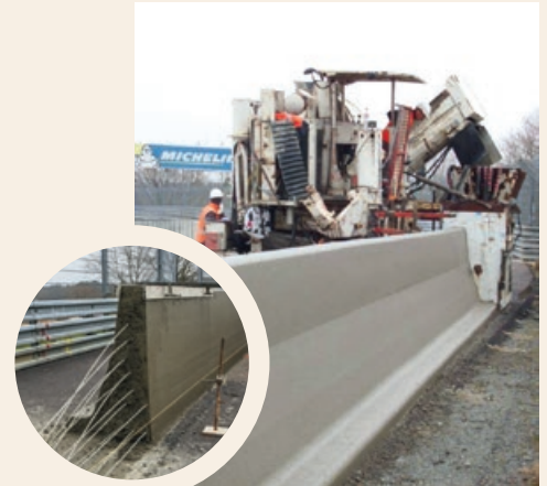
Les glissières FIA-FIM comportent 17 filants métalliques (torons).
