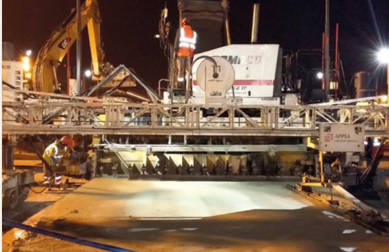
Parmi les réalisations : des chaussées aéronautiques de 37 cm d'épaisseur.
