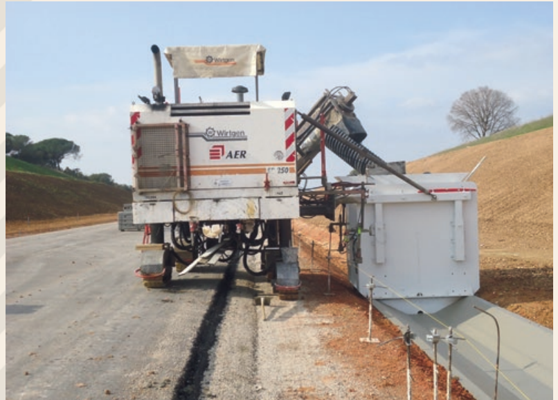
Sur le chantier du CNM, le déplacement par zone (« zoning ») a imposé un rythme de mise en œuvre soutenu pour pouvoir suivre les avancées du terrassement.
