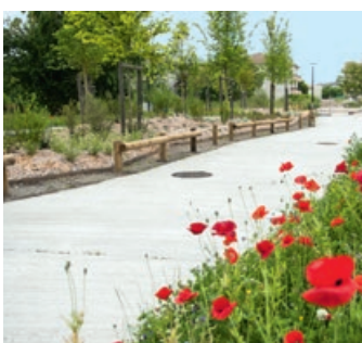
PHOTO DE COUVERTURE // À Bègles (Gironde), un ambitieux projet urbain participatif, à forte dimension environnementale, s'achève. Mis en œuvre par Sols-Aquitaine, le béton balayé y apporte une valeur ajoutée esthétique et contemporaine.
