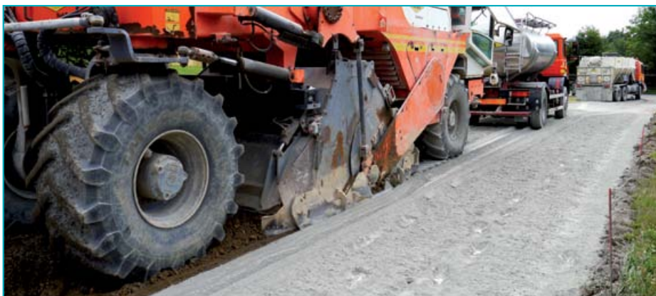
Après une passe de chaque côté, la troisième passe est centrale : elle permet de retraiter à nouveau une partie de chacune des deux couches précédentes, d'où une homogénéité finale encore meilleure.
