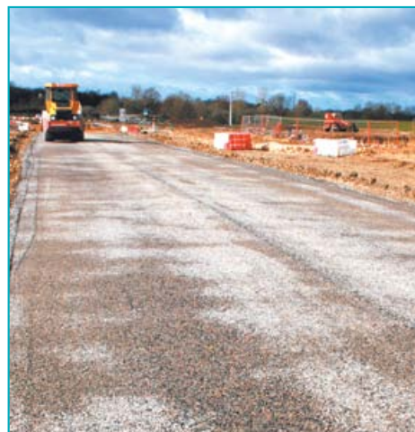
Deux phases successives de compactage suivent le passage de la niveleuse : à gauche, la première phase est réalisée avec un compacteur à pneus, à droite la seconde phase avec un compacteur vibrant.
