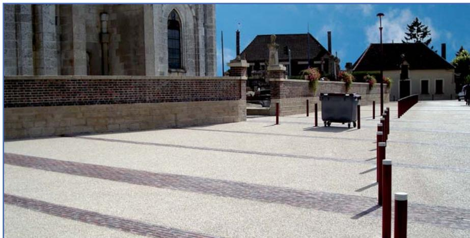
granulats clairs "comblanchiens" (calcaires de teinte beige et de dureté comparable à celle du marbre) rappelant la façade de l'église et grâce à la réalisation d'un calepinage en briques rouges, identiques à celles des murs de l'église.
