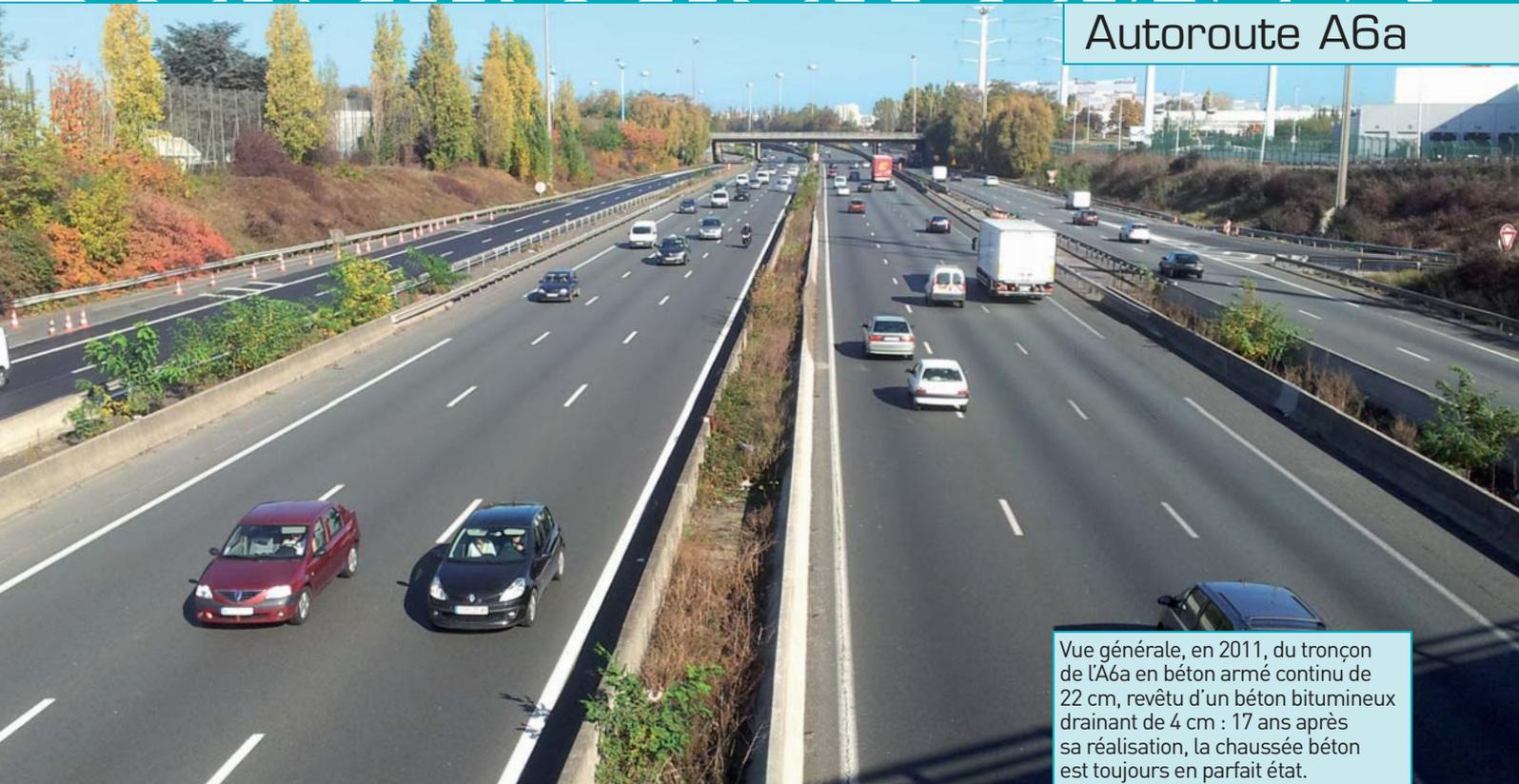
Vue générale, en 2011, du tronçon de l'A6a en béton armé continu de 22 cm, revêtu d'un béton bitumineux drainant de 4 cm : 17 ans après sa réalisation, la chaussée béton est toujours en parfait état.
