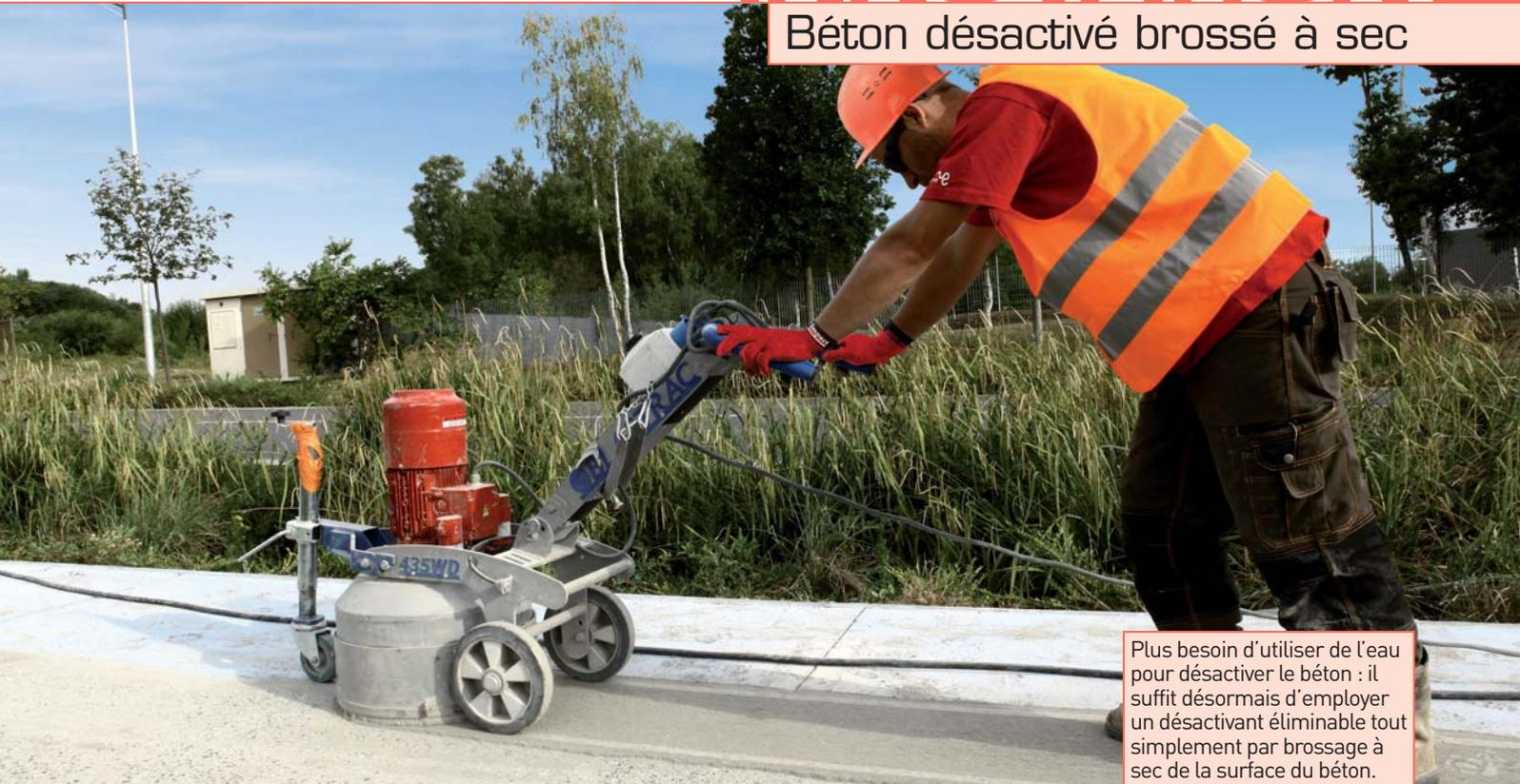
Plus besoin d'utiliser de l'eau pour désactiver le béton : il suffit désormais d'employer un désactivant éliminable tout simplement par brosse à sec de la surface du béton.
