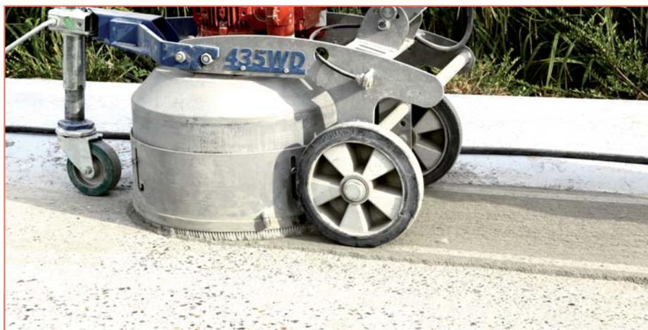
Grâce au brossage à sec le lendemain du coulage, le béton traité avec l'émulsion désactivante CHRYSO® Déco Brush se révèle d'un aspect parfait et la totalité des résidus peut ainsi être récupérée.
