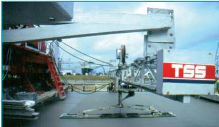
La surface du béton armé continu est lissée par une taloche de grande dimension.
