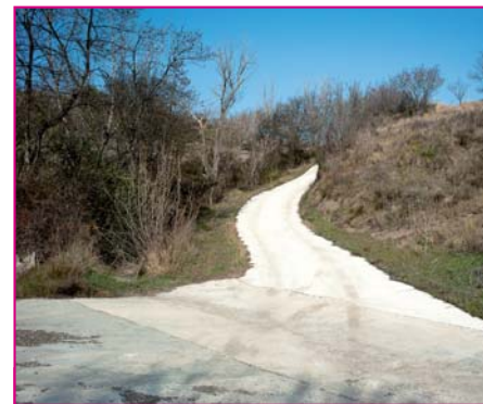
Une partie des caniveaux, guidant l'eau jusqu'au dispositif naturel d'évacuation, a aussi été réalisée en béton.
