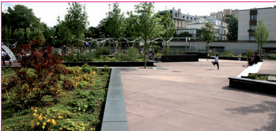
Les murets et les bancs sont en béton gris anthracite. Ils sont lasurés et hydrofugés sur le chantier, afin de les protéger et de leur donner des reflets mats, rappelant l'aspect du plomb des vitraux de l'église.
