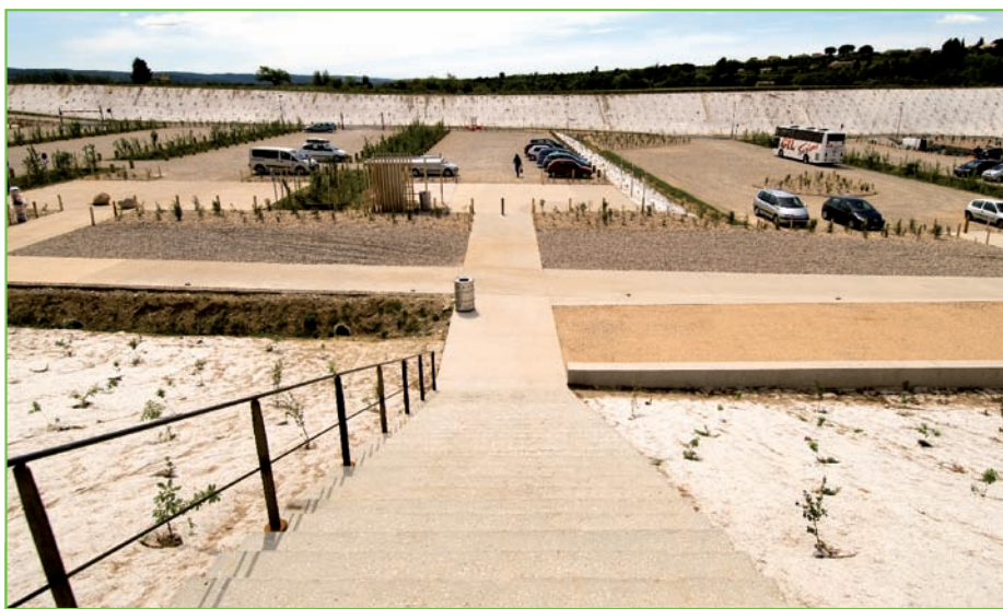
Les nombreux escaliers du site ont été traités en béton sablé.
