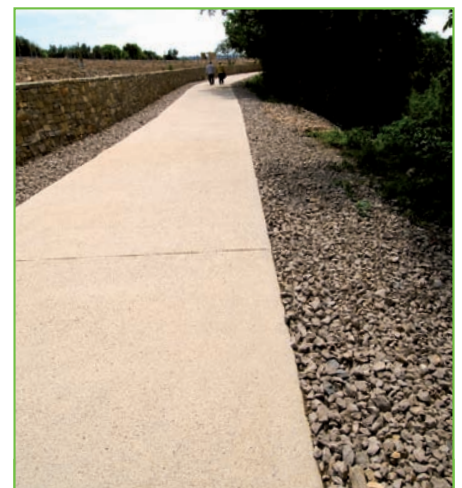
Les bords des cheminements ont été arrondis afin de les fondre dans le paillage de granulats qui les borde.
