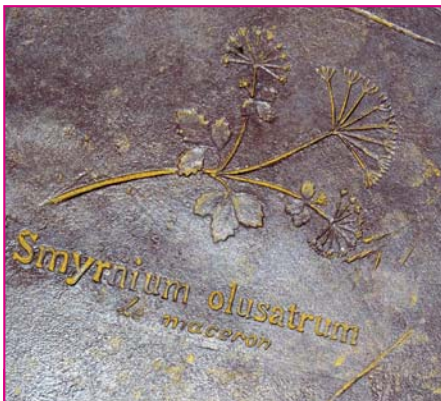
En surface du béton ont été imprimées des illustrations de plantes et d'aiguilles de pin, présentes sur le site.
