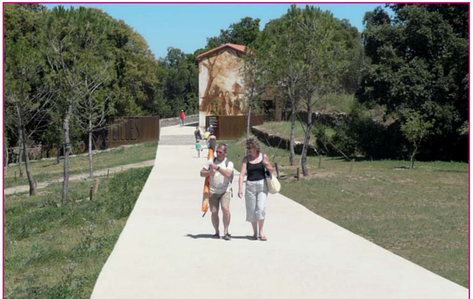
Le cheminement, qui relie le parking à la plage, a été réalisé en béton sablé très lumineux. Sur ce matériau passent jusqu'à 2 800 piétons par jour en été, ainsi que les véhicules d'entretien et de secours.
