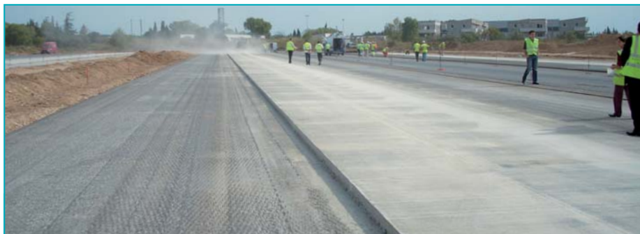
La couche de grave bitume est fraisée pour avoir une surface rugueuse (à gauche) et permettre ainsi au BCMC (à droite) d'adhérer parfaitement au support.
