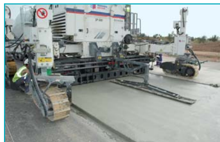
Lissage du BCMC à l'aide d'une poutre placée à l'arrière de la machine.
