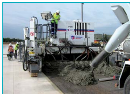
La machine à coffrage glissant est alimentée par des toupies à l'avant.
