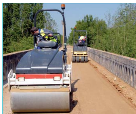
Après le passage du malaxeur, la voie est compactée.
