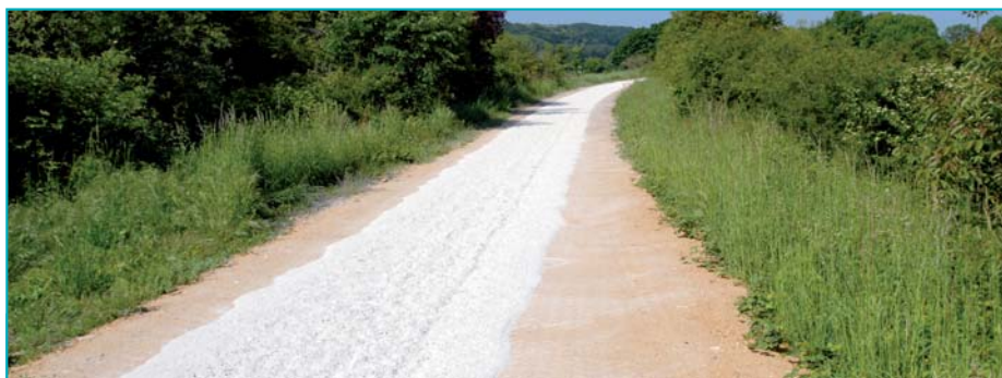
La stabilisation du sol est réalisée par épandage régulier d'un liant hydraulique routier, composé de chaux hydraulique naturelle et d'un liant à effet pouzzolanique.
