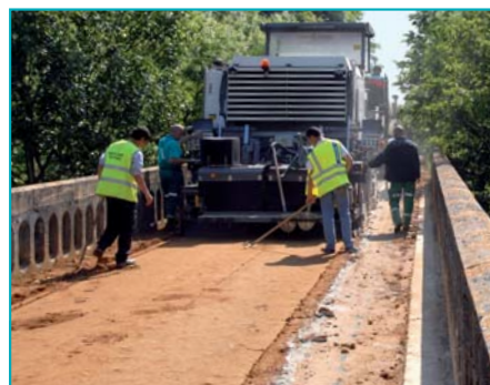
Le malaxeur mélange le liant hydraulique routier avec le sable en place.
