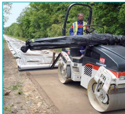
Après compactage, un film polyane est déroulé pour protéger la voie.
