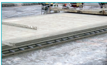
Au total : 16 000 m 2 de dallage en béton pour le parking fret et 27 000 m 2 pour le parking passagers.
