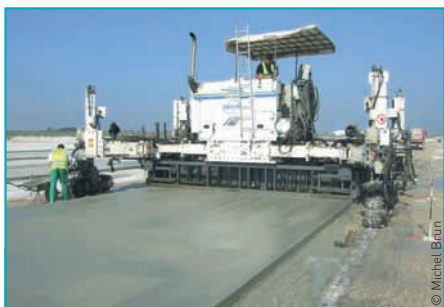
Les dallages en béton ont été réalisés avec une machine à coffrage glissant.
