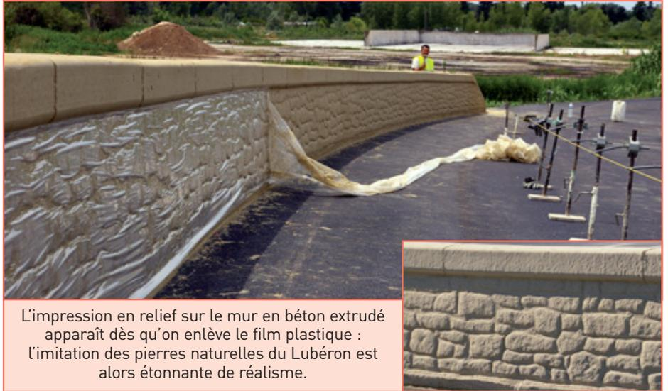
L'impression en relief sur le mur en béton extrudé apparaît dès qu'on enlève le film plastique : l'imitation des pierres naturelles du Lubéron est alors étonnante de réalisme.
