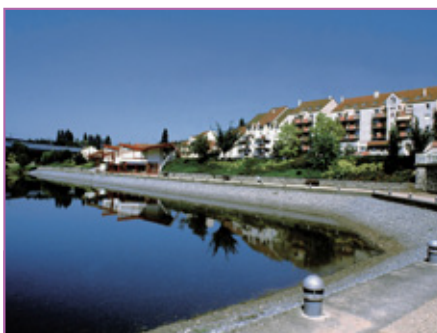
Massy : les berges du plan d'eau de la mairie, en cailloux de béton concassé.
