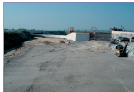
Roissy : la grave de béton concassé utilisée en remblais d'ouvrage d'art.
