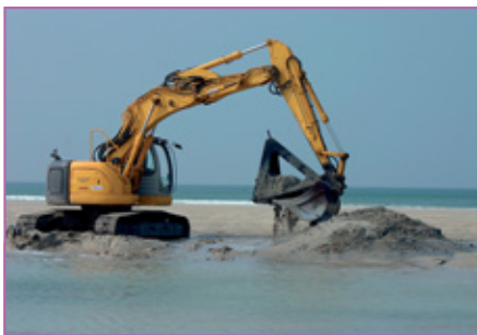
Baie d'Audierne : les tétraèdres en béton armé, restes du Mur de l'Atlantique.
