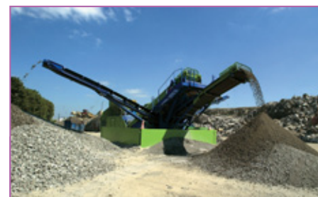
La chaîne de production aboutit à la réalisation de la grave de béton.
