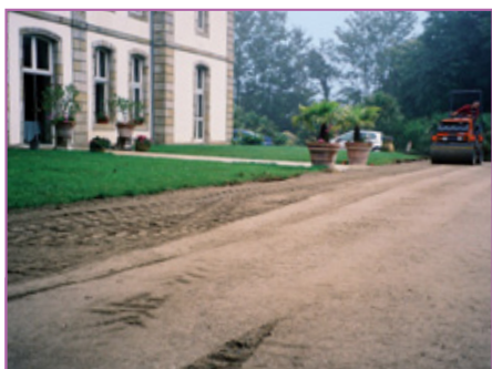
Manoir Madec à Quimper : mise en œuvre de la grave de béton concassé 0/20.
