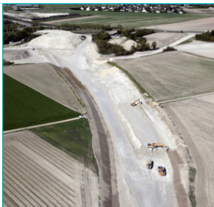
Le dernier tronçon de la rocade a nécessité le terrassement de 900 000 m 3 .
