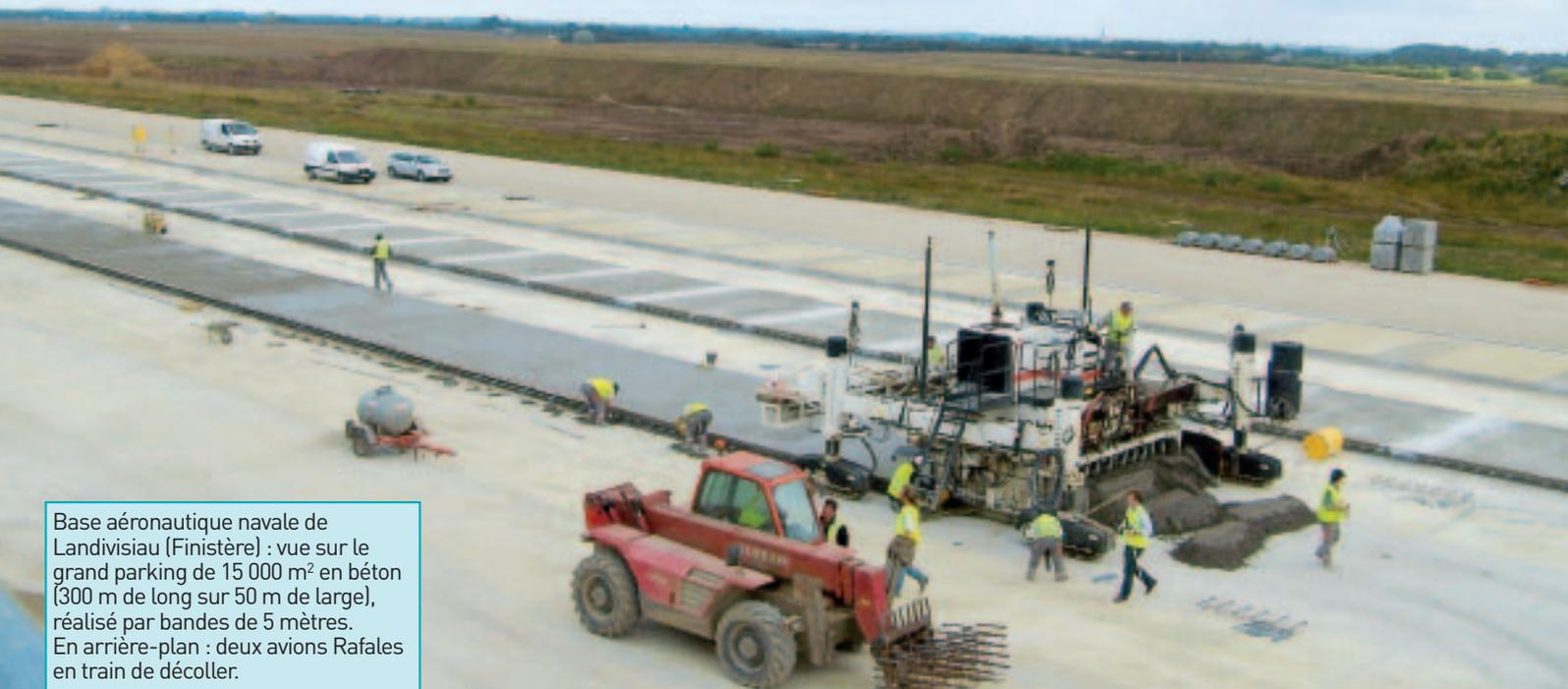
Base aéronautique navale de Landivisiau (Finistère) : vue sur le grand parking de 15 000 m<sup>2</sup> en béton (300 m de long sur 50 m de large), réalisé par bandes de 5 mètres. En arrière-plan : deux avions Rafales en train de décoller.
