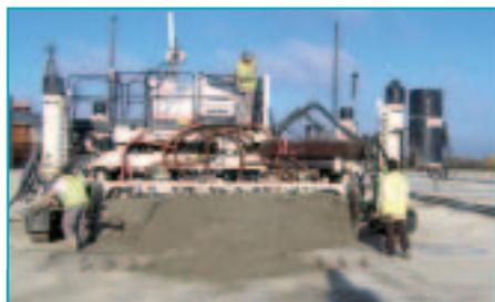
L'absence de fils et de potences permet aux maçons d'évoluer librement autour de la machine à coffrage glissant.
