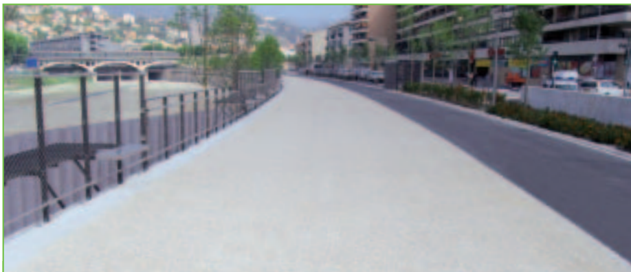
Nice (Paillon) : la promenade en béton désactivé longe la rivière.
