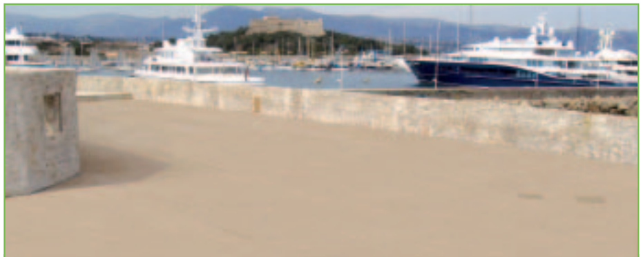
Antibes (Bastion Saint-Jaume) : la terrasse de 1 500 m 2 en béton désactivé, matériau retenu par les Bâtiments de France.
