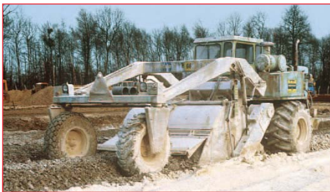
La technique du traitement des sols à la chaux, au ciment et aux liants hydrauliques routiers est de plus en plus utilisée pour les terrassements, mais aussi pour la réalisation des couches d'assises de chaussées.
