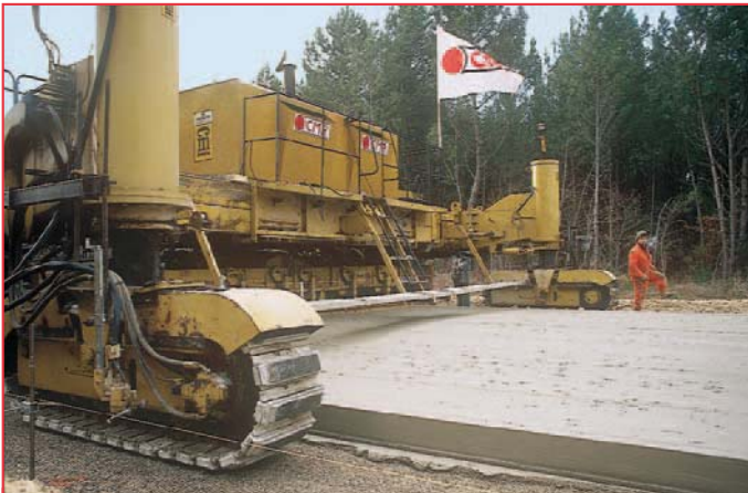
Le béton peut aussi être formulé à partir du sable présent localement, comme sur cette route expérimentale en béton de sable, à la dune du Pyla (Landes).
