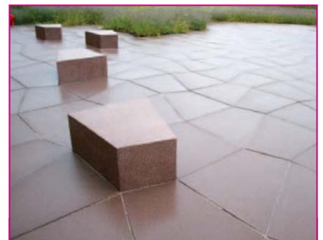
Le parvis de dalles en béton, dessinées par Ursula Kurz et dont certaines ont été surélevées pour faire office de bancs.
