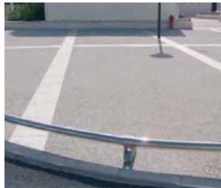
Toulouges : les trottoirs des abords du centre culturel ont été réalisés en béton désactivé avec un granulat local.
