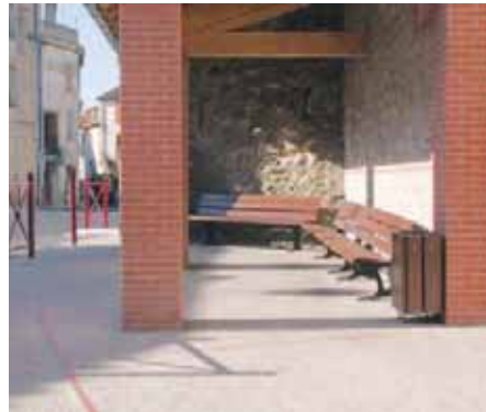
Trouillas : pour ses espaces piétons, la commune a fait appel au béton désactivé, calepiné de briquettes rouges.
