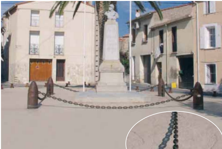
Palau del Vidre : la place du monument aux morts a été coulée en béton imprimé. Les motifs pierre confèrent à l'espace un aspect éminemment naturel.
