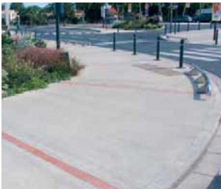
Toulouges : le béton balayé est le plus souvent calepiné de briques rouges pour respecter la tradition architecturale locale.
