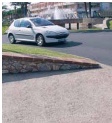
Saint-Cyprien : l'une des nombreuses communes qui a fait appel au béton désactivé pour les cheminements piétons.
