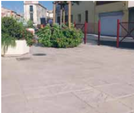
Trouillas : le parvis de la mairie a été réalisé en béton imprimé à motif de dalles en pierres de formats différents.
