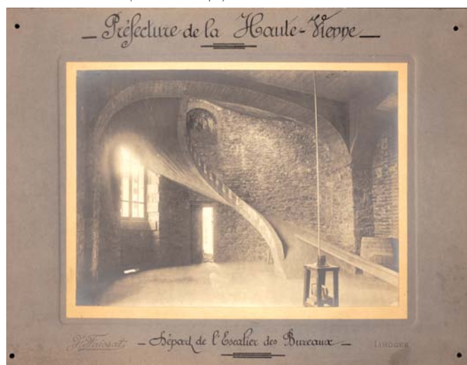
Préfecture de la Haute-Vienne, Limoges (Haute-Vienne) : départ de l'escalier des bureaux (Fonds Hennebique).
