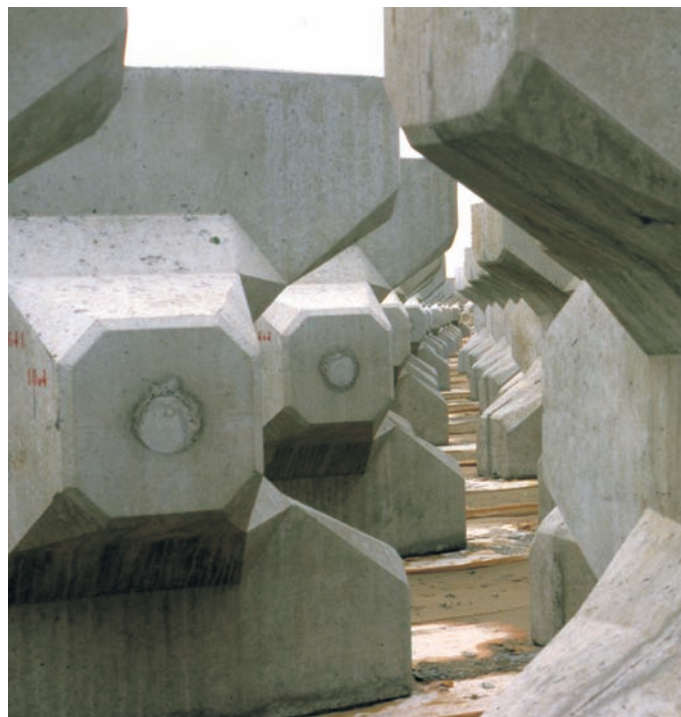
Blocs en béton préfabriqués pour la confection de digues et de quais.
