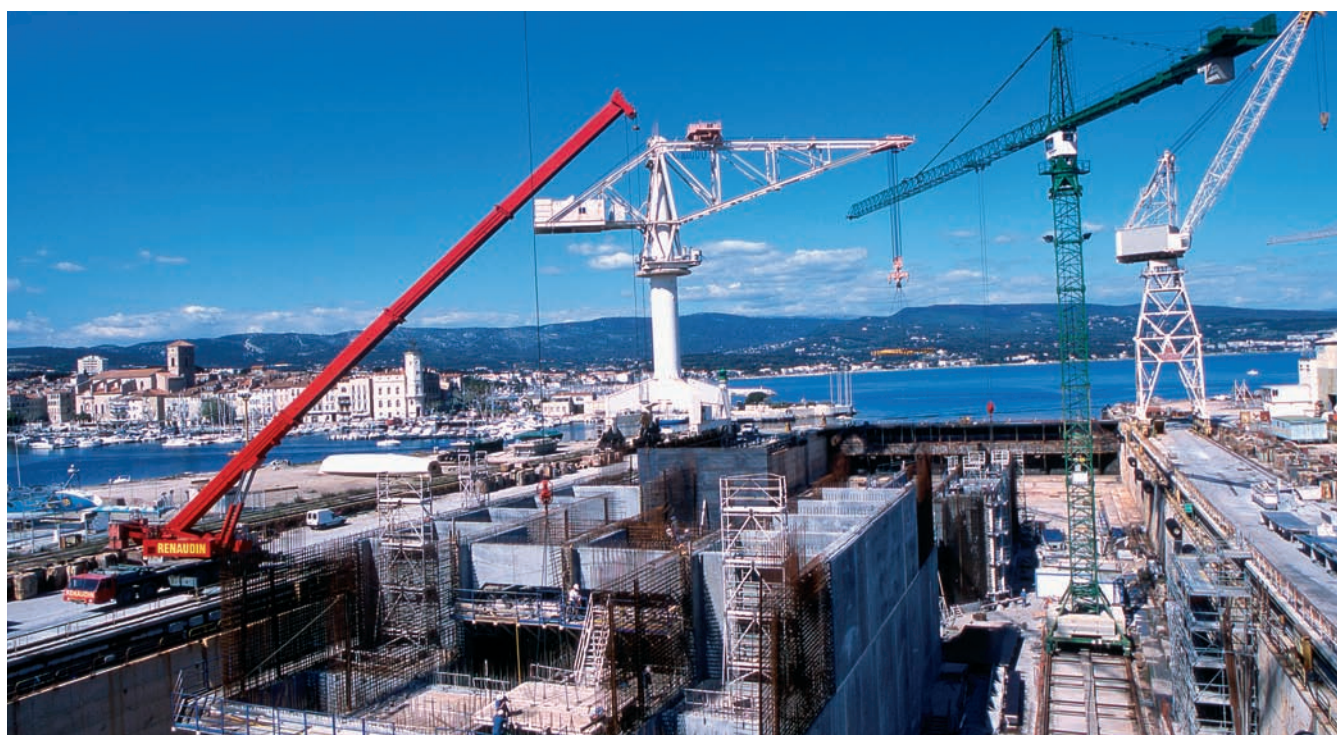
Chantier en site maritime.
