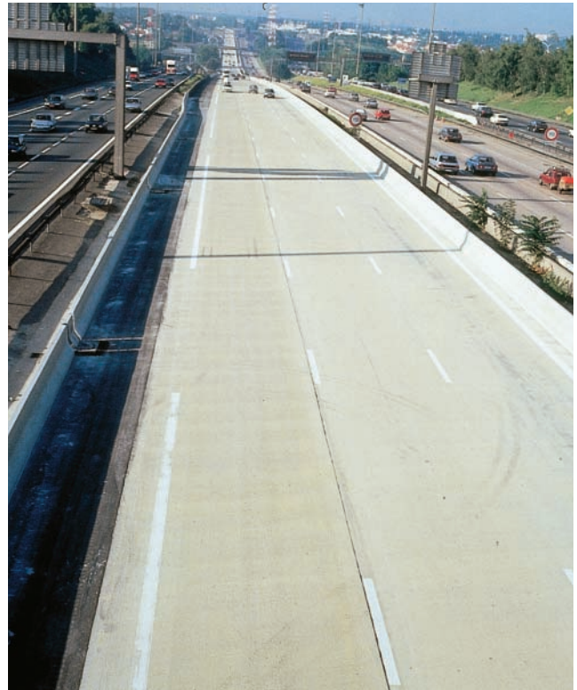
Chaussée autoroutière en béton : surlargeurs non circulées bordant le revêtement côté BAU (à gauche) et côté BDG (à droite).
