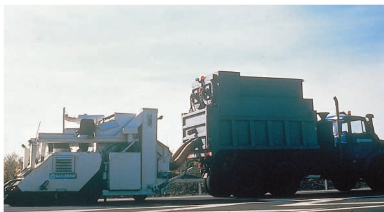
Atelier de grenailage : nettoie et régénère la rugosité d'un revêtement béton.
