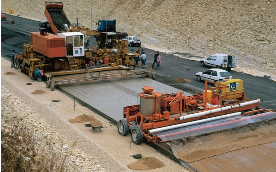
Chaussée composite en BAC/GB : atelier de mise en œuvre.
