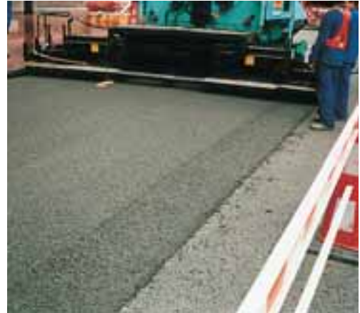
Réalisation d'une structure réservoir en bétons poreux.
