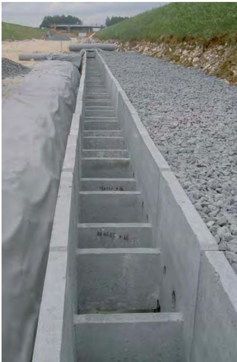
La collecte et l'évacuation des eaux de ruissellement des plates-formes ferroviaires peuvent s'effectuer au moyen de fossés ou de caniveaux préfabriqués en béton.
