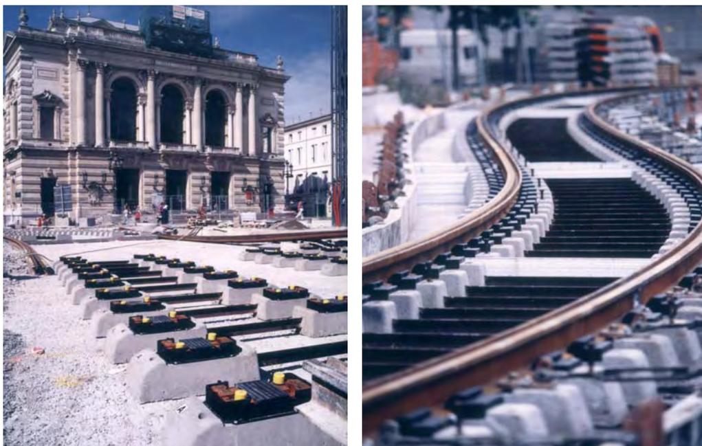
**Voies anti-vibratiles pour tramway**
