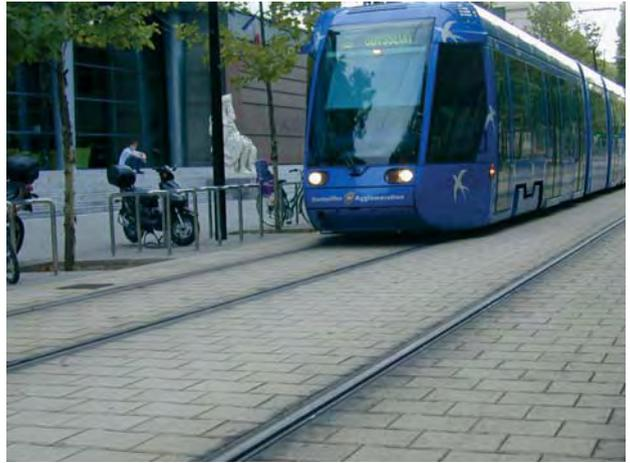
**Plate-forme de tramway en pavés béton**
