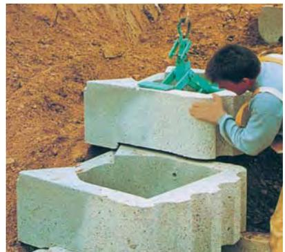
Pour faciliter leur décalage, les éléments sont parfois équipés d'une butée avant ou de chevrons arrière, qui participent également à la résistance mécanique de l'ouvrage.
