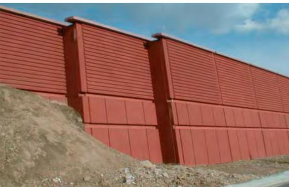
L'amélioration des performances acoustiques d'un ouvrage existant est possible en habillant le mur en place avec un revêtement constitué d'éléments en béton réfléchissant. Cette solution, souvent composée d'éléments de petites dimensions (dallettes), permet de rendre absorbants les écrans réfléchissants et les murs de soutènement préexistants.
