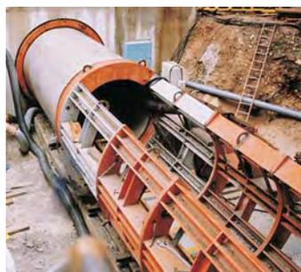
Les tuyaux en béton offrent une large gamme de diamètres allant jusqu'à 3200 mm, ce qui permet la prise en compte de forts débits générés par des événements pluvieux importants.
