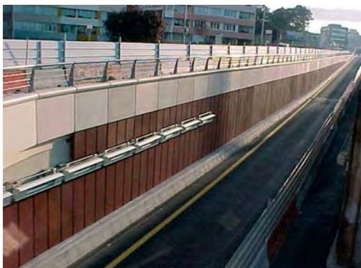
Afin d'atténuer l'énergie acoustique rayonnée à la sortie d'un tunnel ou d'une tranchée couverte, il est possible d'équiper les parois des ouvrages de panneaux absorbants autoporteurs ou habillés de dalles en béton absorbant.
