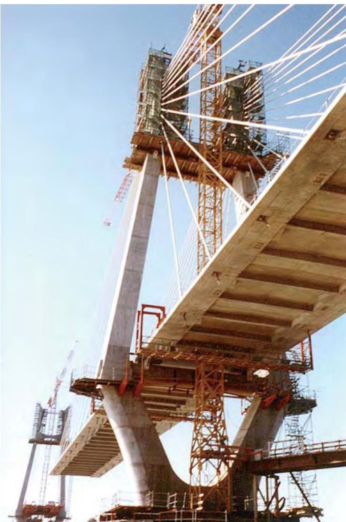
L'utilisation de pièces de pont préfabriquées en Béton Haute Performance (résistance à 28 jours supérieure à 60 MPa minimum) permet un gain de temps et une simplification des phases de réalisation des ouvrages à haubans ou suspendus. L'épaisseur moyenne du tablier peut être réduite, ce qui entraîne son allègement.
