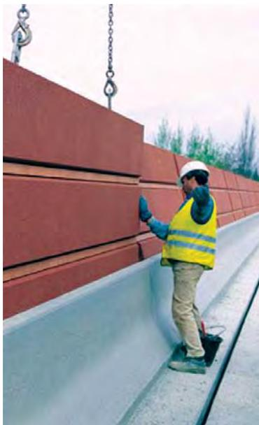
Ces ouvrages associent les écrans acoustiques aux dispositifs en béton assurant la sécurité et jouent la double fonction de sécurité et d'acoustique.
