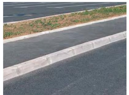
Les bordures et caniveaux préfabriqués en béton offrent des aspects très diversifiés :
