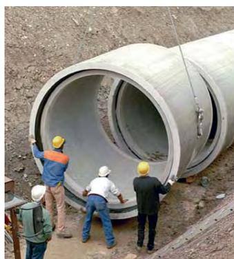
**Canalisation en béton de grand diamètre posée par fonçage**
