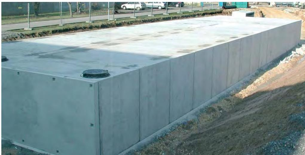
**Ouvrage de rétention des eaux pluviales**
