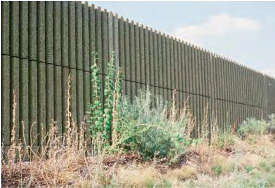
Il est possible dans certains cas de supprimer les poteaux. Les efforts sont dans ce cas transmis directement à la semelle par la structure porteuse du panneau préfabriqué.
