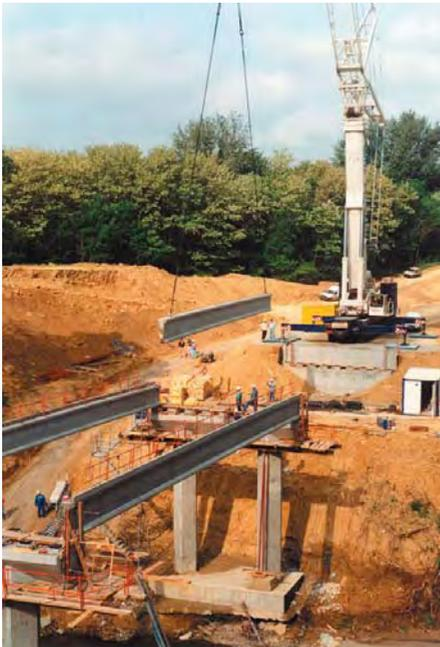
La mise en place définitive des poutres sur chantier se fait à l'aide de grues ou d'engins de levage légers à des cadences de pose de l'ordre de 15 à 30 minutes par poutre. Des dispositifs de sécurité permettent d'assurer la stabilité des poutres en phase de construction.
