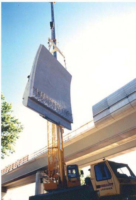
L'offre de produits préfabriqués en béton pour écrans acoustiques comprend, en particulier, des solutions adaptées à une utilisation sur les ouvrages d'art.
