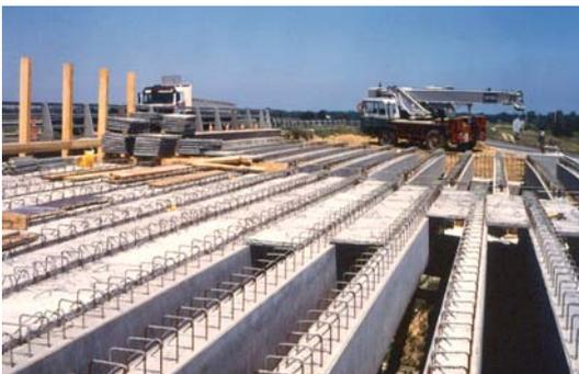
Dans le cas d'ouvrages de type ponts poutres PRAD hyperstatiques, le décintrement des appuis provisoires des poutres peut s'effectuer lorsque la résistance du béton de deuxième phase atteint environ 18 MPa.
