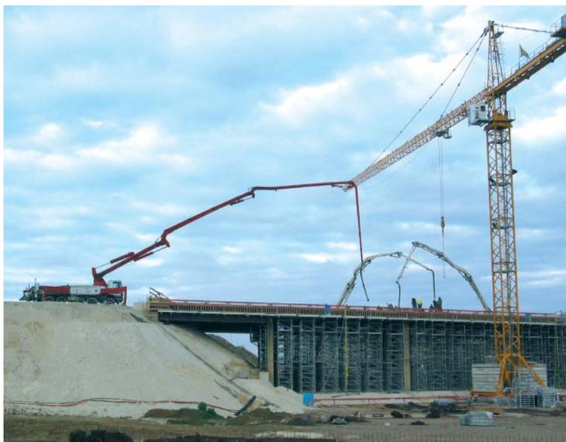
métriques de l'ouvrage, du plan de bétonnage et de la cadence de pompage retenue par l'entreprise et imposée par le système d'étaie afin d'assurer une bonne répartition des charges sur l'ouvrage en cours de bétonnage.
