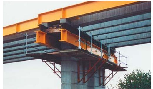
Après la pose des poutres, on procède à la mise en place des coffrages des hourdis centraux entre les poutres (en général coffrage perdu) et à celle, éventuellement, des encorbellements puis des coffrages des entretoises d'about.
