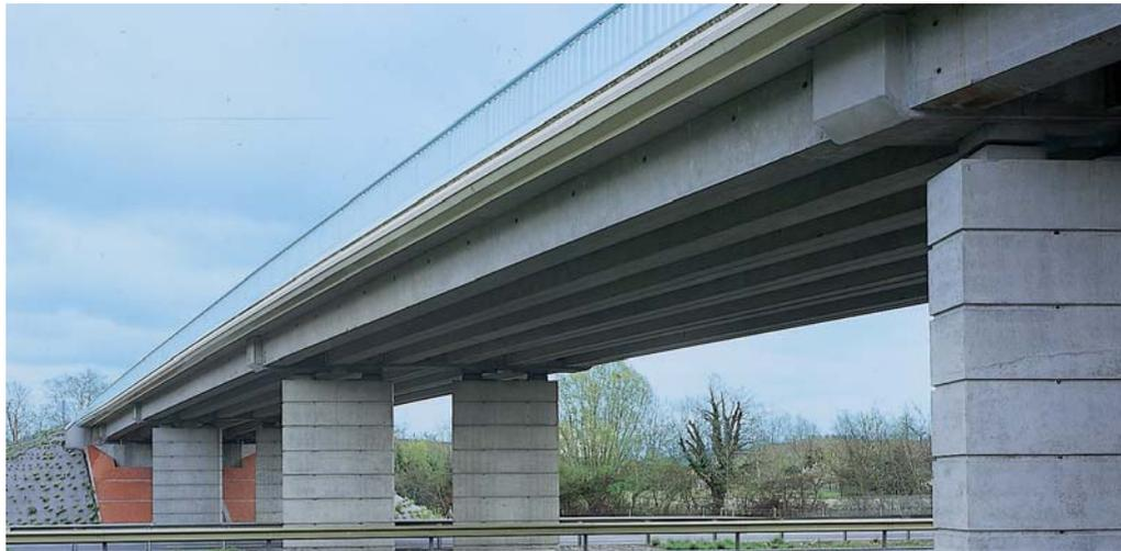
Les ponts PRAD sont devenus, depuis de nombreuses années, une solution classique pour la réalisation de ponts routiers ou autoroutiers dans la gamme des portées de 10 à 35 m (passages inférieurs, passages supérieurs, ouvrages à plusieurs travées isostatiques ou hyperstatiques).
