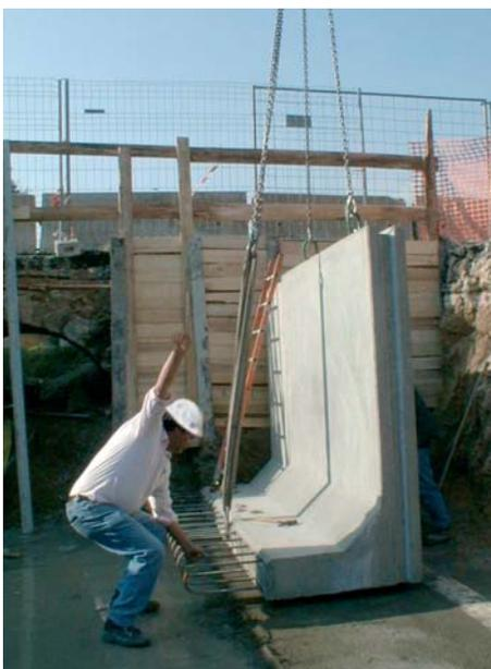
Le choix des méthodes de pose, des étalements provisoires, des dispositifs de sécurité et de stabilité en phase de construction est effectué par l'entreprise générale. Le préfabricant indique les endroits où les éléments peuvent être appuyés provisoirement durant la construction.
