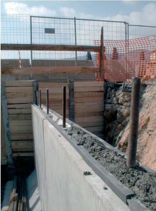
**Mortier d'appui sous dalle de cadre**
