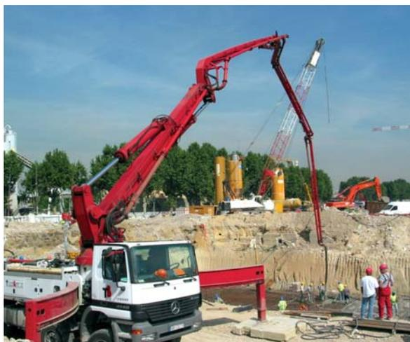
Dans le cas d'utilisation d'une seule pompe, le bétonnage débutera, en principe, à partir d'une culée, du point bas de l'ouvrage vers son point haut.
