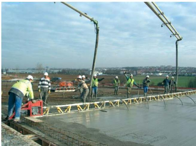
Le bétonnage à la pompe permet de libérer la grue de chantier qui peut ainsi être affectée à d'autres tâches.
