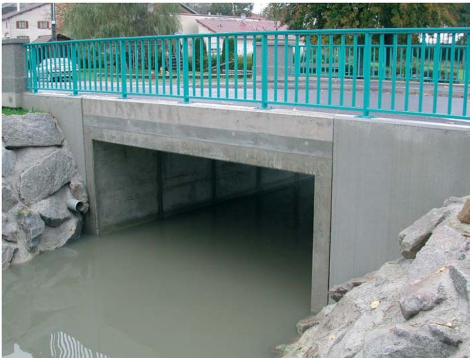
**Cadre monolithique préfabriqué en béton**
