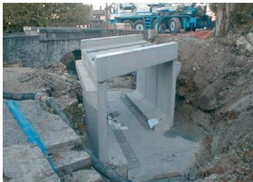
Toutes les précautions doivent être prises, pour assurer la stabilité de l'ouvrage lors du compactage des remblais autour de l'ouvrage et pour drainer les eaux d'infiltrations.
