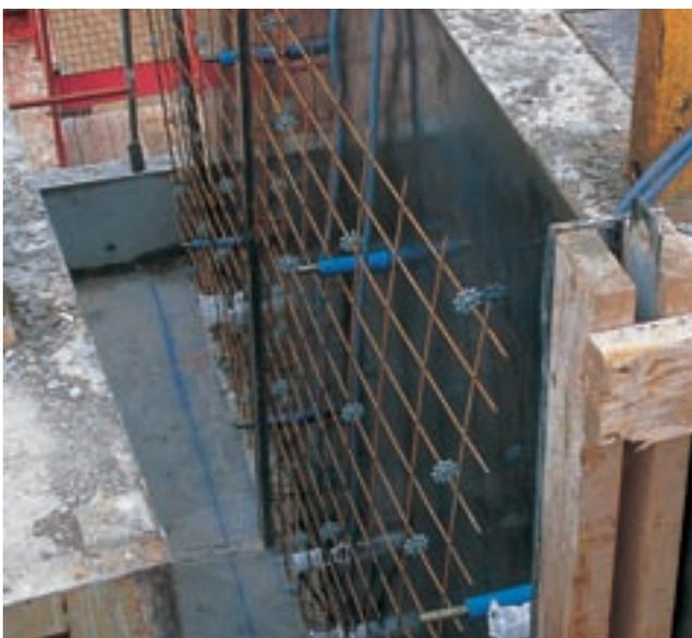
« armatures assemblées » d'un modèle standard, constituées par assemblage des armatures coupées façonnées sous forme de « cages » ou de « panneaux » et utilisées par des applications courantes (semelles de fondation, poteaux, linteaux, etc.).
