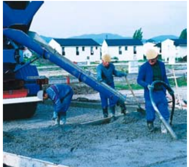
L'aiguille vibrante : un matériel devenu d'utilisation courante.
