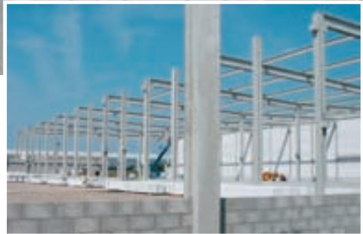
Les murs en béton préfabriqués forment un compartimentage résistant pour ces installations de stockage en construction.
