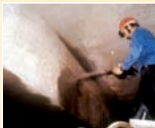
Réparation des parties endommagées en projetant du béton.
