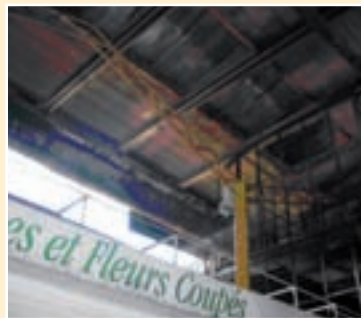
Les dégâts à l'intérieur de l'entrepôt, ont été rapidement réparés.
