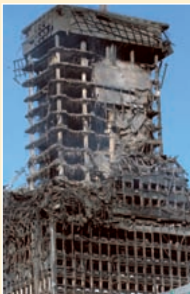
La façade qui se trouvait au-dessus de l'étage technique au niveau 16 a été totalement détruite.
