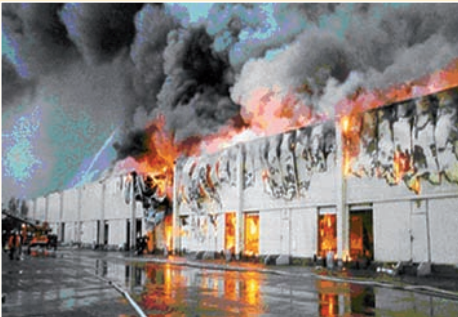
Les panneaux sandwich, métalliques et légers, ont cédé dans cet incendie d'un abattoir à Bordeaux, en janvier 1997. L'incendie s'est propagé dans tout le bâtiment et les bâtiments adjacents.
