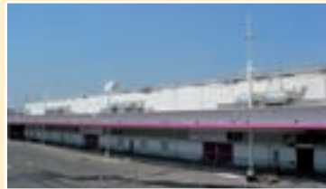
Vue extérieure de l'entrepôt de fleurs de Rungis, qui a pu reprendre son activité six mois après l'incendie.
