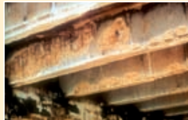
Exemple d'éléments en béton après l'incendie, sur lesquels l'écaillage est visible.
