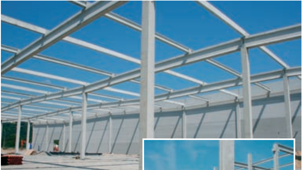
Les murs en béton préfabriqués forment un compartimentage résistant pour ces installations de stockage en construction.
