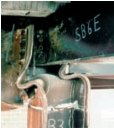
Tête de colonne d'acier gravement déformée par un incendie.
