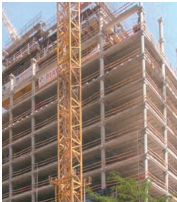
Les North Galaxy Towers de Bruxelles. Ce bâtiment de 30 étages en béton armé répond aux strictes exigences en matière de résistance au feu (REI 120); les poteaux sont en béton C80/95 à haute résistance.
