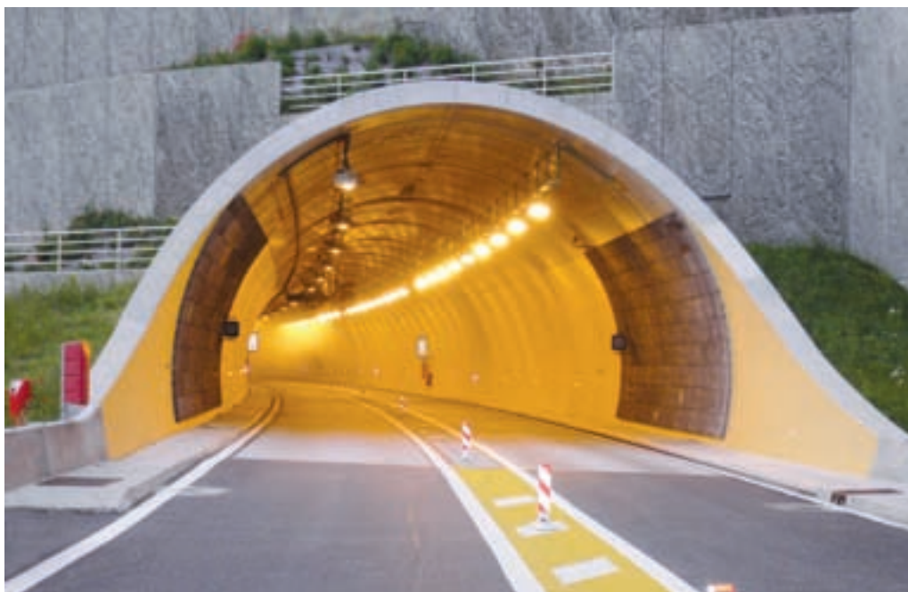
Les tunnels et les revêtements routiers à base de béton peuvent supporter des conditions extrêmes d'incendie. Tunnel du Sinard (A51), Coynelles, Col du Frau, France. La chaussée en béton n'apporte pas de potentiel calorifique supplémentaire. L'évacuation des usagers et l'intervention des sapeurs-pompiers sont facilitées.
