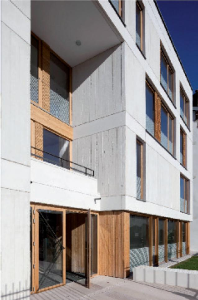
*Façade sur rue. Elle décline une composition régulière, sobre et élégante de panneaux préfabriqués en béton brut de décoffrage de couleur beige clair alternant surface lisse et surface rainurée.*
