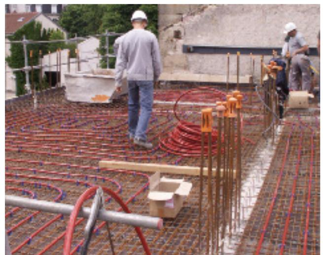
*Le chauffage des locaux en hiver et leur rafraîchissement en été sont assurés par un plancher chauffant/rafraîchissant, qui utilise l'inertie thermique du béton. Chaque plancher est parcouru par un réseau de tuyaux intégré au cœur de la dalle en béton armé et dans lequel circule de l'eau. Vue de la mise en place des tuyaux.*
