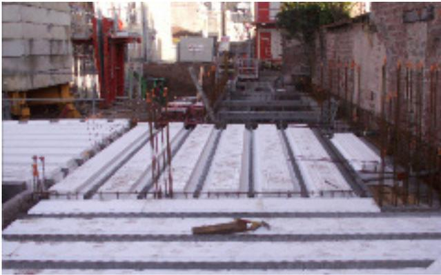
*Le plancher du rez-de-chaussée, construit sur un vide sanitaire inondable, est composé de poutres préfabriquées en béton précontraint et de hourdis polystyrène de 30 cm qui assurent l'isolation en sous-face de la dalle.*
