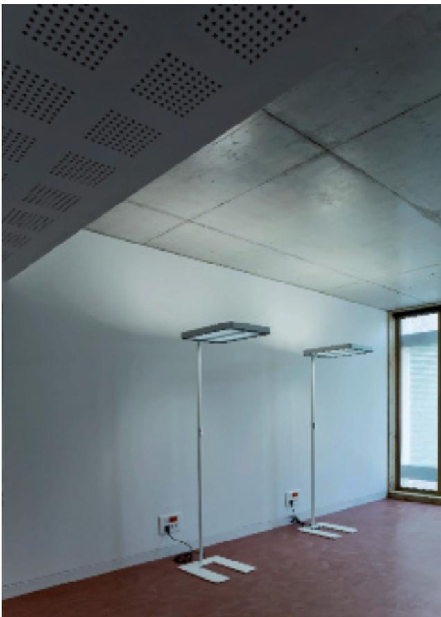
*L'un des grands bureaux. Le plafond est en grande partie laissé brut de décoffrage pour le fonctionnement optimum de la dalle de plancher/chauffant rafraîchissant.*
