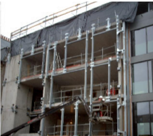
Vue des rails métalliques sur lesquels seront accrochés les panneaux en béton préfabriqués de la façade.
