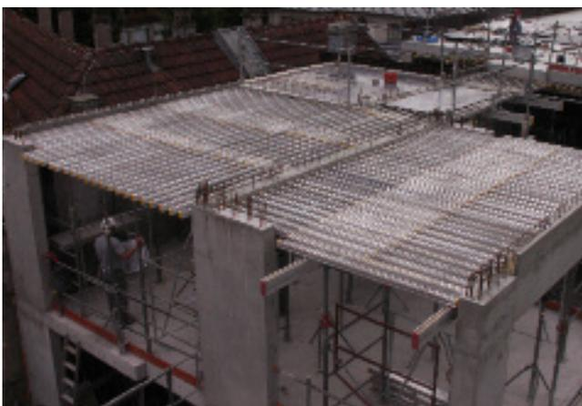
*Pour chaque plancher d'étage, du premier niveau à la toiture-terrasse, la mise en œuvre est identique dans les deux corps de bâtiment. Les plaques horizontales de coffrage sont portées par un système d'étalement constitué de poutrelles en aluminium très rapprochées les unes des autres.*
