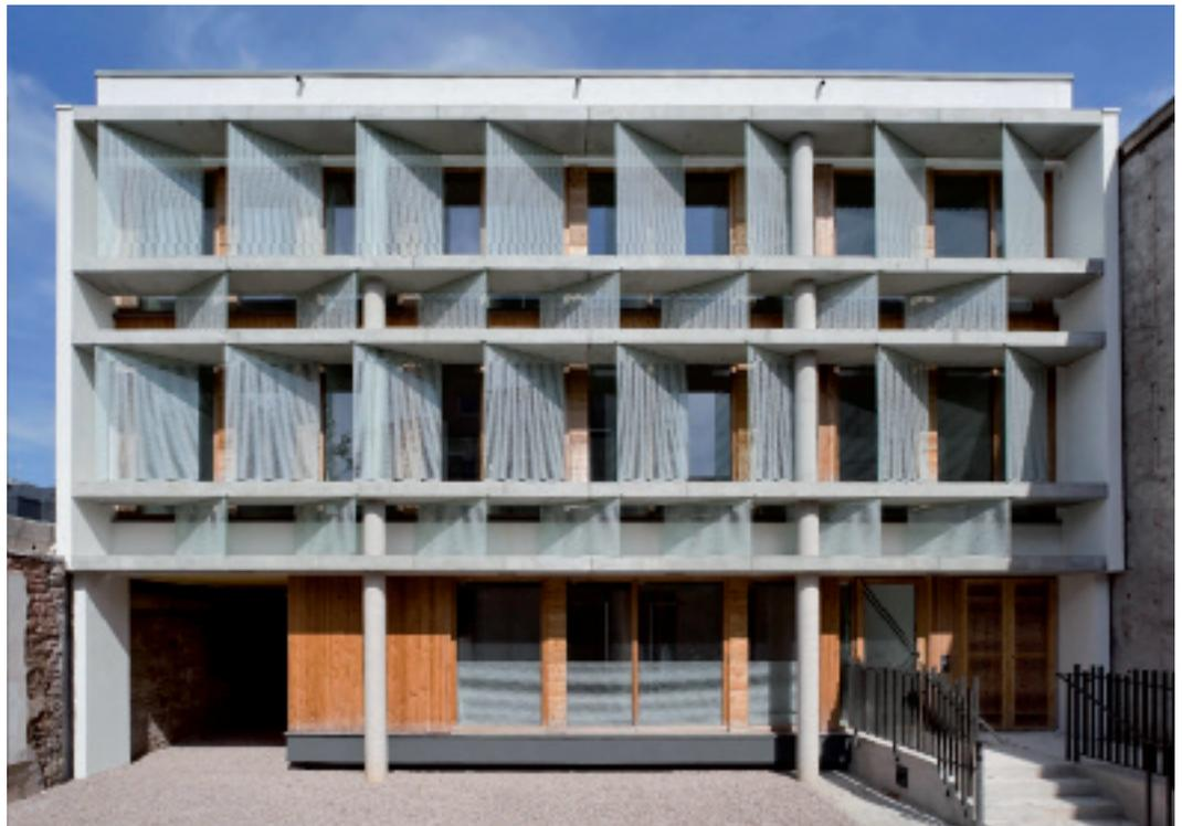
*Façade sud-ouest du corps de bâtiment en cœur de parcelle, protégée du rayonnement solaire direct par un puissant brise-soleil en béton dans lequel sont enchâssées des lames verticales de verre sérigraphié*
