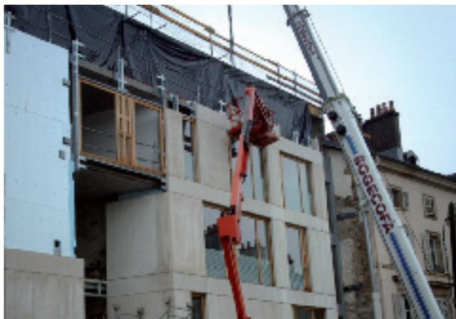
*L'accrochage des panneaux en béton sur les rails métalliques et la mise en place de l'isolant thermique (ici, entre, une paroi de béton coulée en place et les panneaux de façade).*
