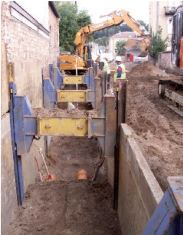
*Vue sur la mise en œuvre du puits canadien, dans une tranchée, le long du mur mitoyen nord.*
