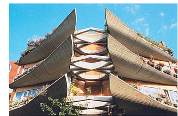
23 Hinrich et Inken Baller architectes Quartier Fraenkelufer, détail des balcons
