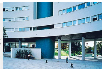
64 Ripault et Duhart architectes 90 logements Gentilly, détail de l'entrée
