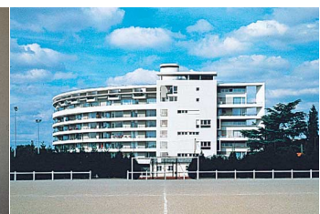
62 Ripault et Duhart architectes 90 logements Gentilly, 1998
