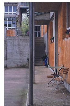
26 Atelier 5 architectes Niederwangen (Bern), Suisse, détail d'un porche d'entrée
