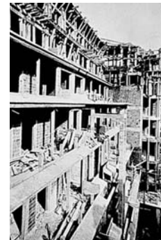
39 Henri Sauvage architecte Immeuble rue des Amiraux, chantier
