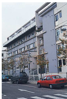
29 Edith Girard architecte Logements zac des bruyères, à Villejuif
