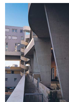
54 Bernard Paurd architecte Immeuble villa à Vitry, vue d'une coursive
