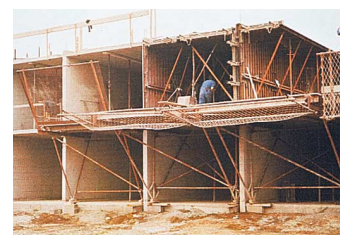
2 Trame systématique de refends transversaux réalisée avec des coffrages tunnels
