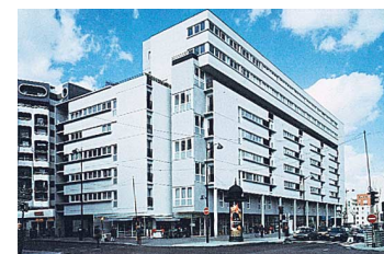
32 Pierre Gangnet architecte Rue de Flandres à Paris, 1995, façade de panneaux préfabriqués
