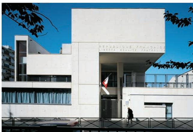
L'usage de béton autoplaçant (BAP) et de coffrages métalliques a été déterminant dans la réalisation de ces façades. La mise en œuvre du BAP a autorisé des coulages en une fois des deux étages, et l'absence de reprise apparente garantissait l'homogénéité du parement. La longueur des linteaux de certaines fenêtres pouvant aller jusqu'à 7 m, la
