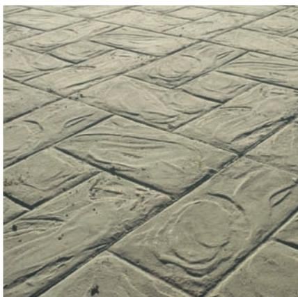
Exemples de bétons imprimés.
