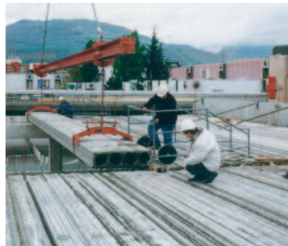
Mise en place de dalles alvéolaires de 16 m de portée.
