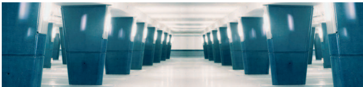
Parc de stationnement, centre d'affaires Opéra-Victoire, Lobjoy & Bouvier Architectes.
