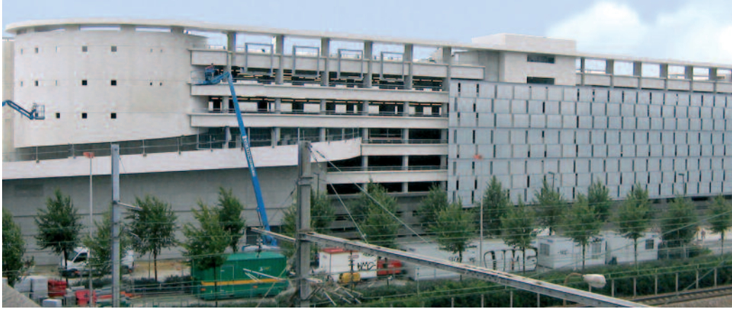
Parking public Bièvre (centre commercial SQY-Ouest), Lobjoy & Bouvier Architectes. Dalles alvéolaires offrant une stabilité au feu de 1 h 30 en partie courante et 3 h 00 au niveau de la voie pompiers centre commercial traversante.
